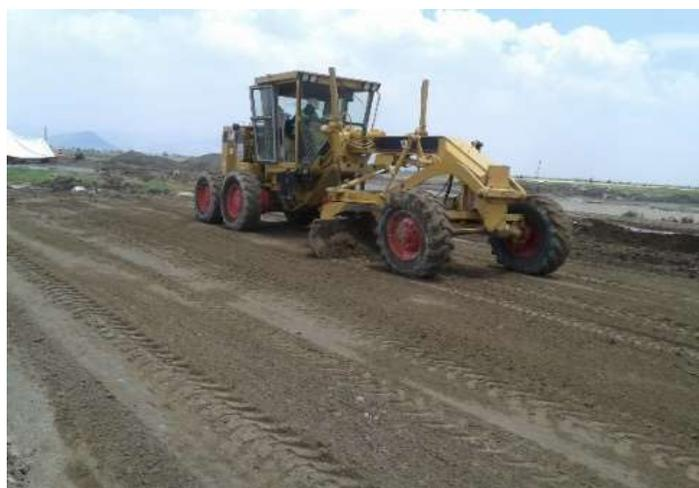
Imagen 9. Nivelación de plataforma con motoconformadora.
