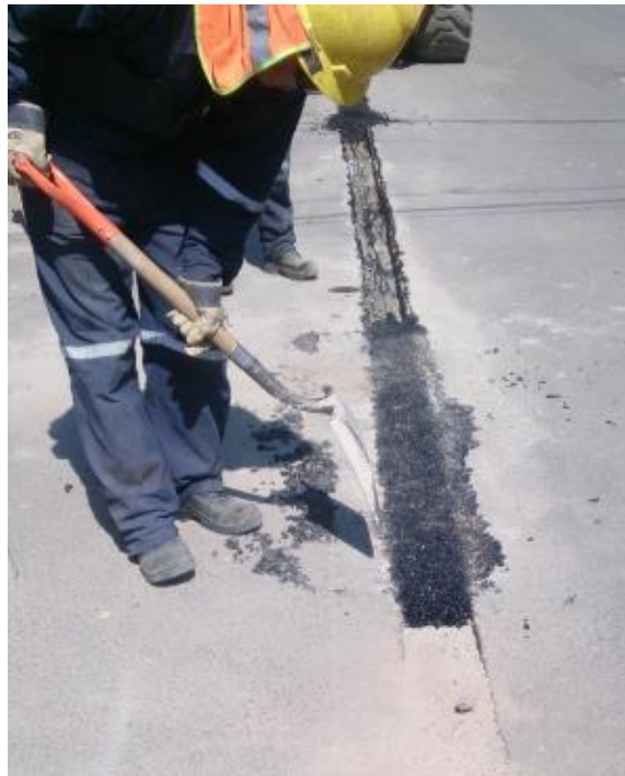
Figura 16. Colocación de la bolsa de BACHEO EN FRÍO.
