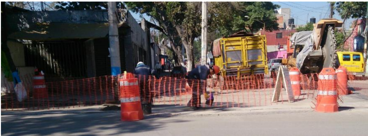
Figura 11. Colocación del producto ligante en la zanja sobre Dr. Barragán.
