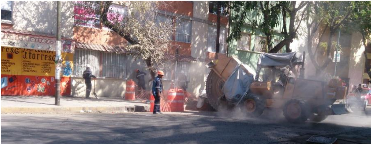
Figura 10. Máquina zanjadora realizando el corte de la carpeta asfáltica.
