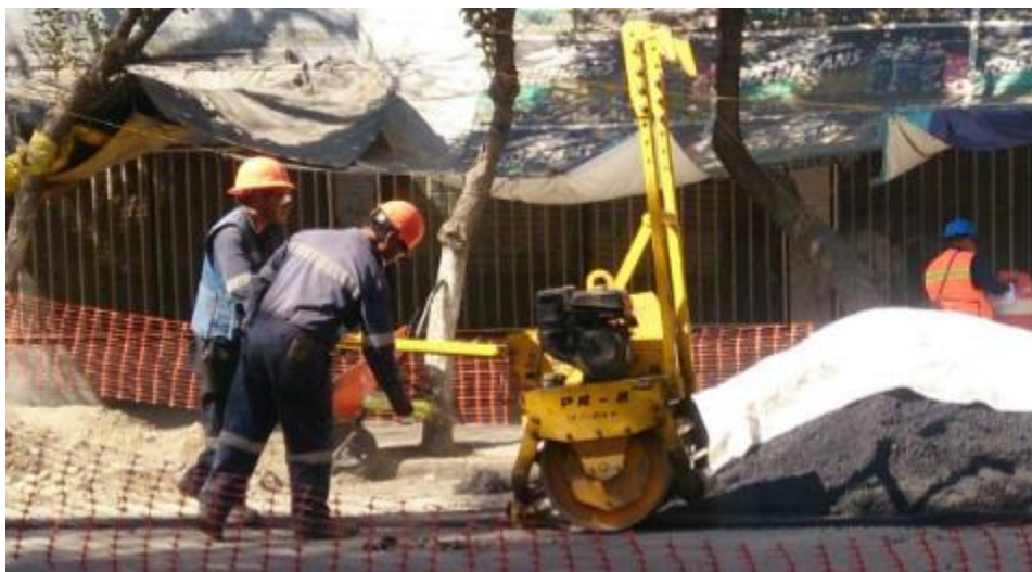
Figura 14. Compactación por medio de rodillo mecánico.
