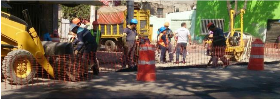
Figura 13. Colocación de la mezcla asfáltica.
