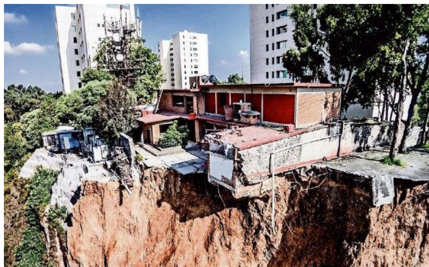
Figura 2. Deslave del talud en Santa Fe. Gerardo Suarez, el universal, 15/11/2015
