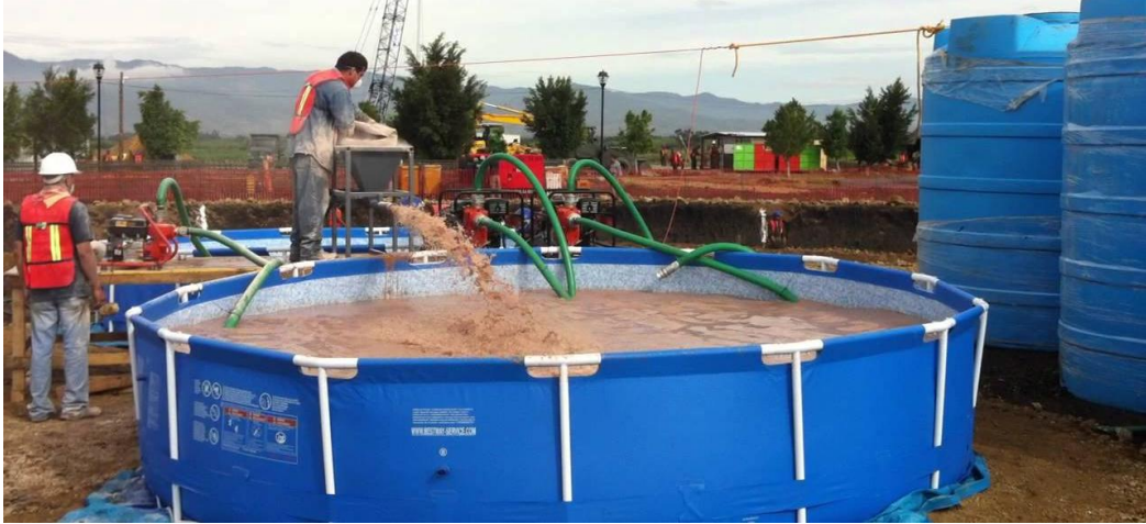
Figura 6. Mezclado y almacenamiento de lodos de perforación
