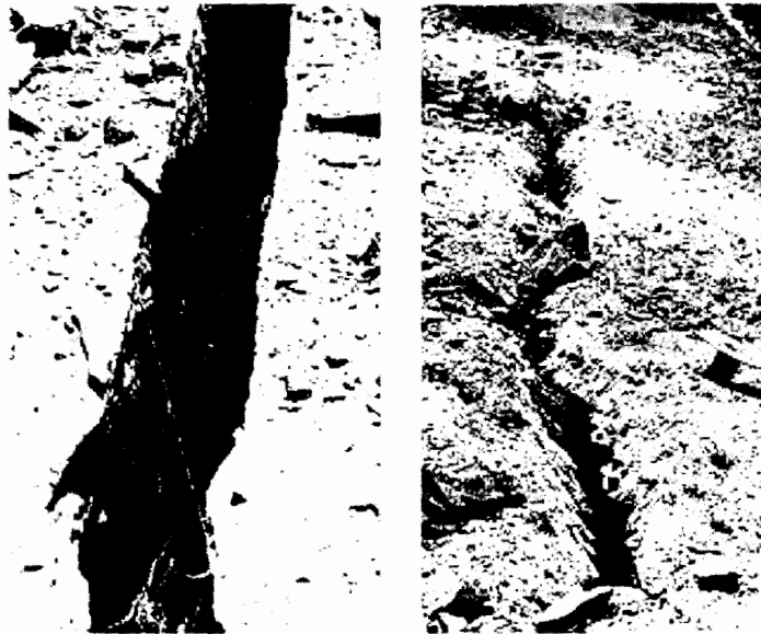
Figura 10.14 Grieta producida por una voladura de precorte
