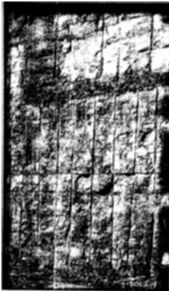
Figura 10.8 Resultados de una voladura de precorte
