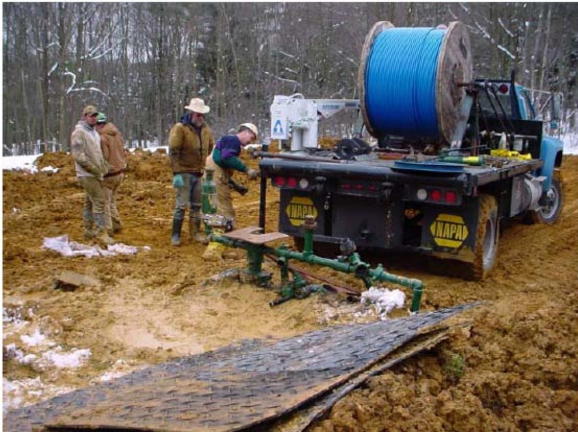
**Fig. 2.10 Instalación de un aparejo de tubería flexible.**
