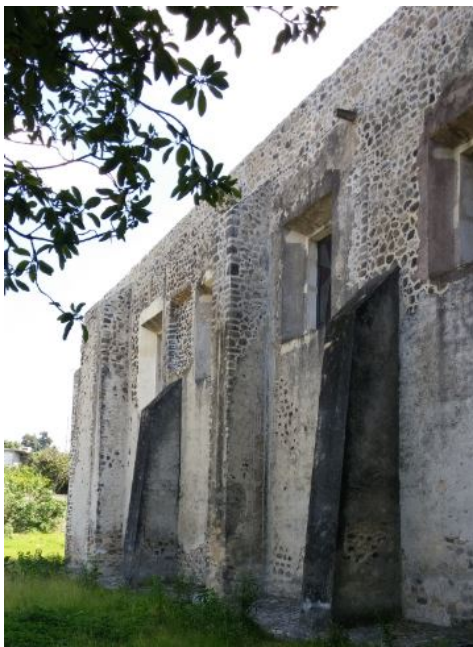
(a) Contrafuertes adosados
