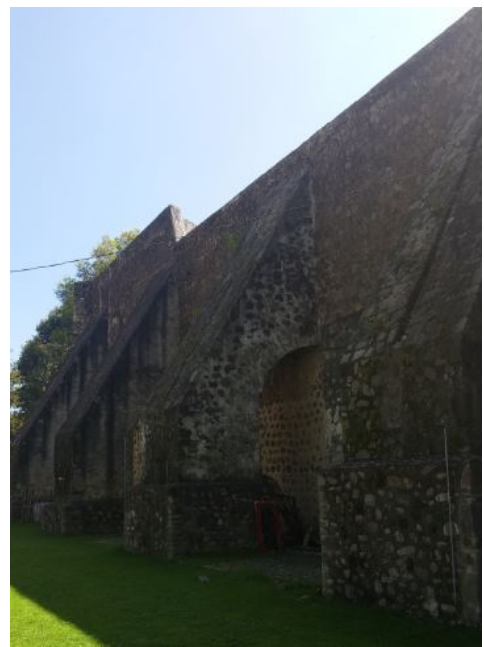
(b) Contrafuertes tipo Botarel
