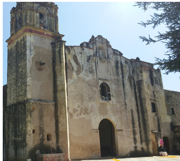
Figura 21: Vista de la fachada principal de Tetela
