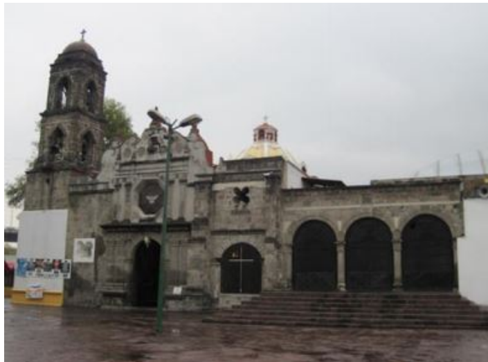
Figura 12: Vista de la fachada principal del templo de San Bartolomé [Robles, 2012]
