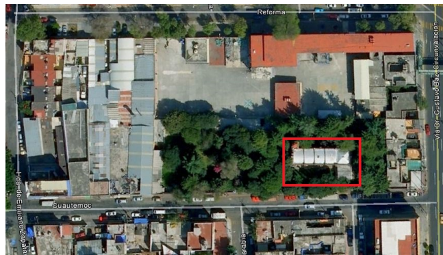
Figura 14: Vista aérea del templo de Nativitas
