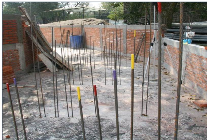
Figura 3.4.2. Colocación de varillas y muros perimetrales
