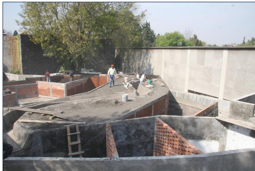
Figura 3.4.4. Colocación de la capa de concreto
