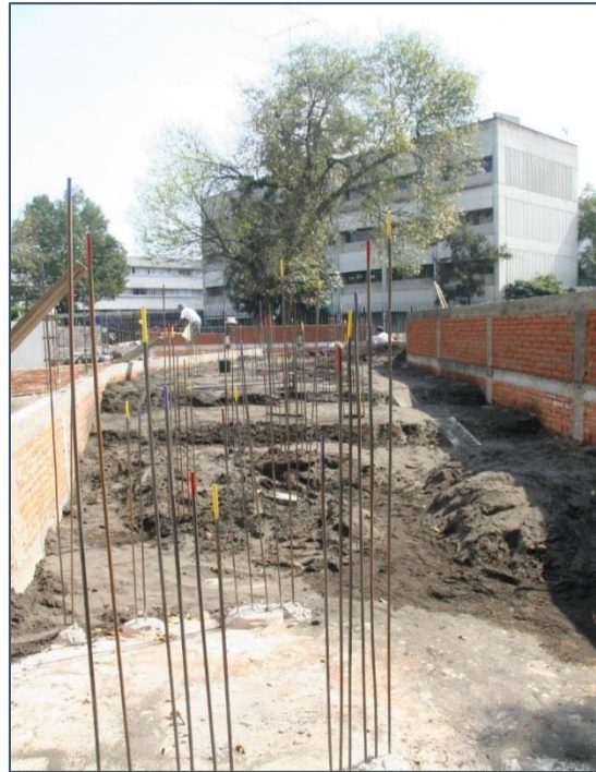
Figura 3.4.3. Colocación de arena
