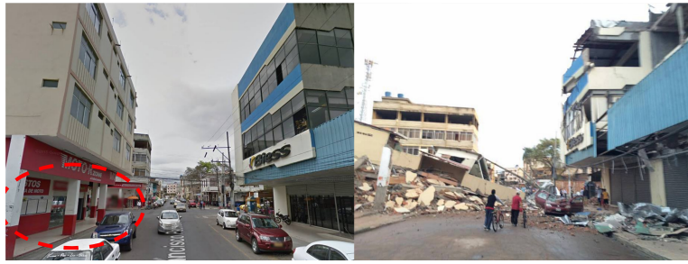
Figura 5: Antes y después de un edificio ubicado en el centro de Poroviejo con piso flexible, durante el sismo de Ecuador 2016. Fuente: Municipio de Balzar.
