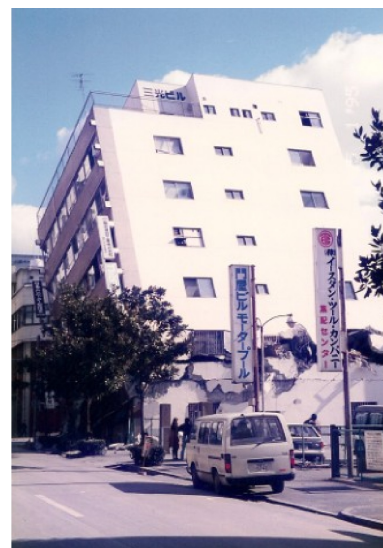
Figura 3: Colapso de un edificio con piso débil, durante el sismo de Kobe, Japón, 1995. Fuente: Tena (2010).
