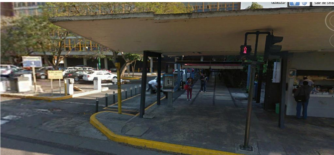
Ilustración 44 Semáforo y acceso principal al estacionamiento N1
