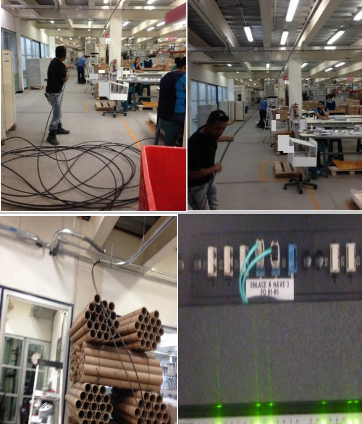
Fotografía 4.2.6b Tendido de fibra óptica en tubería desde el site de nave 3 hasta gabinete de oficinas
