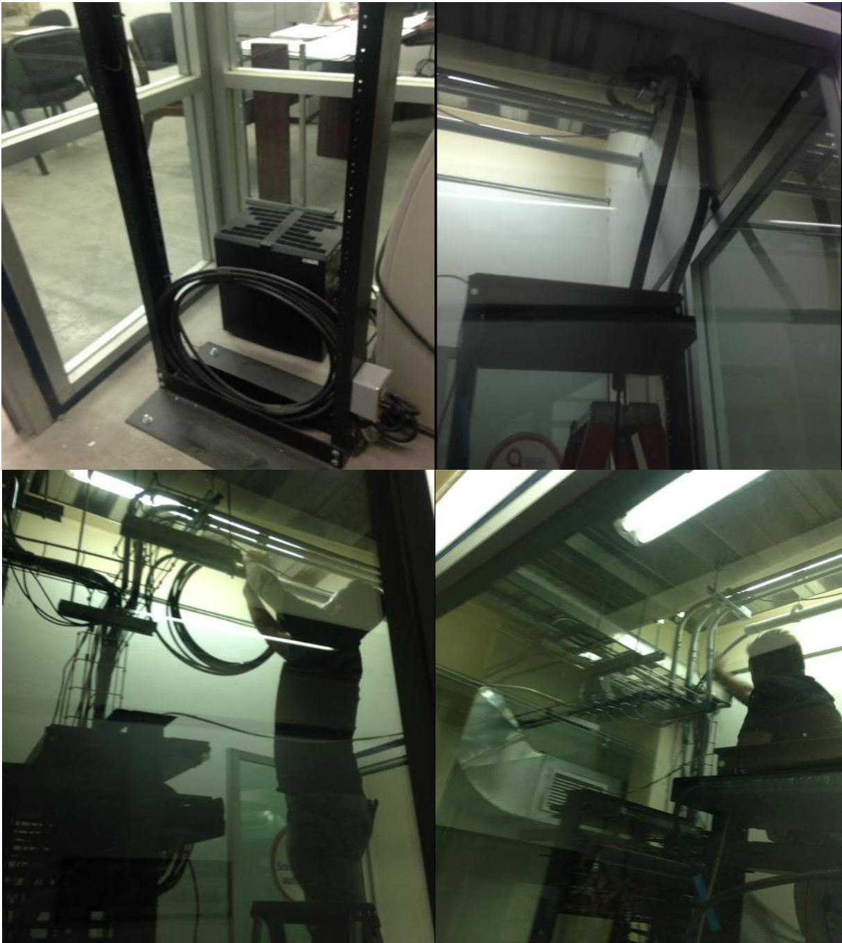
Fotografía 4.2.4 Adecuaciones e instalaciones de mejora en el site de Nave 3
