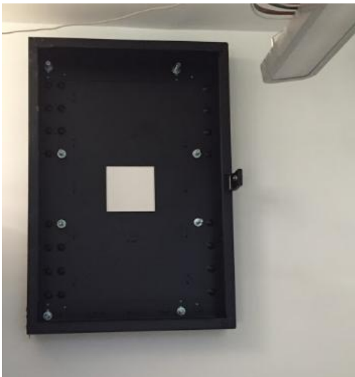
Fotografía 4.2.3a Instalación de soporte
