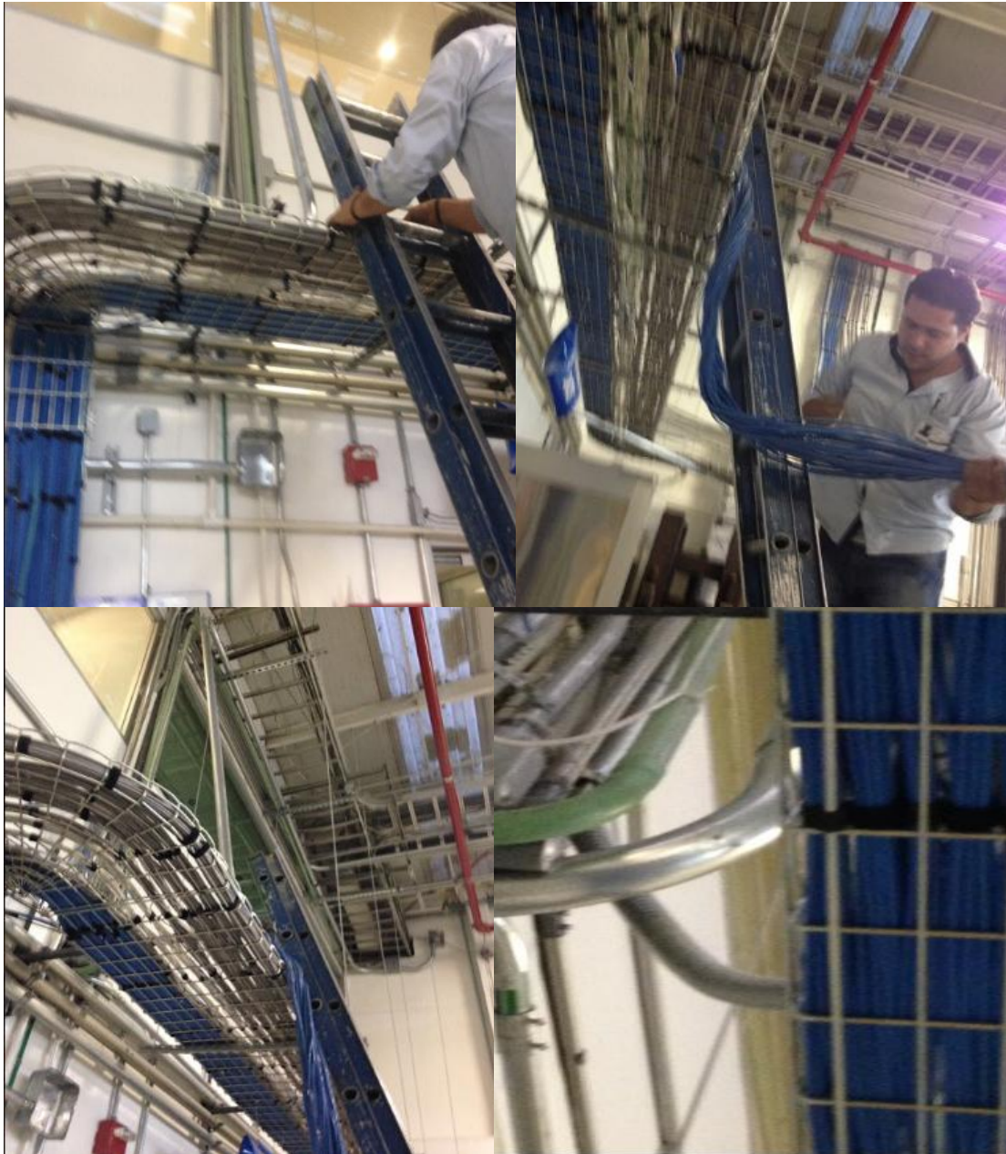
Fotografía 4.1.3 Retiro del cableado en canaletas
