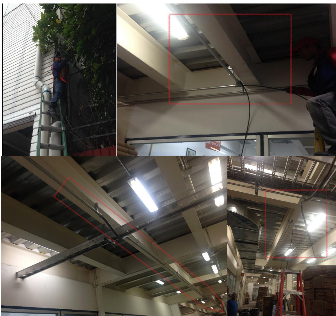
Fotografía 4.2.5a. Canalización para el tendido de fibra óptica
