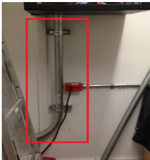
Fotografía 4.2.3e Instalación de canalización para equipos de oficinas
