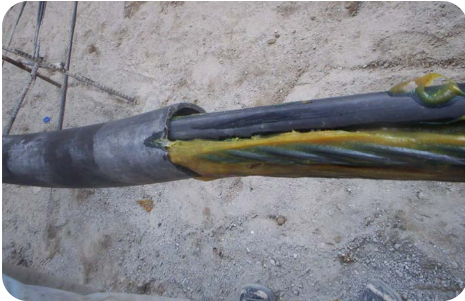
Figura 10. Funda de protección rellena con grasa
