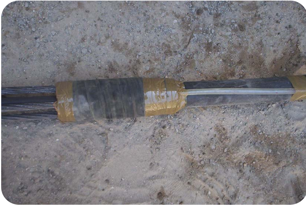
Figura 12. Obturador instalado con su manguera de aire
