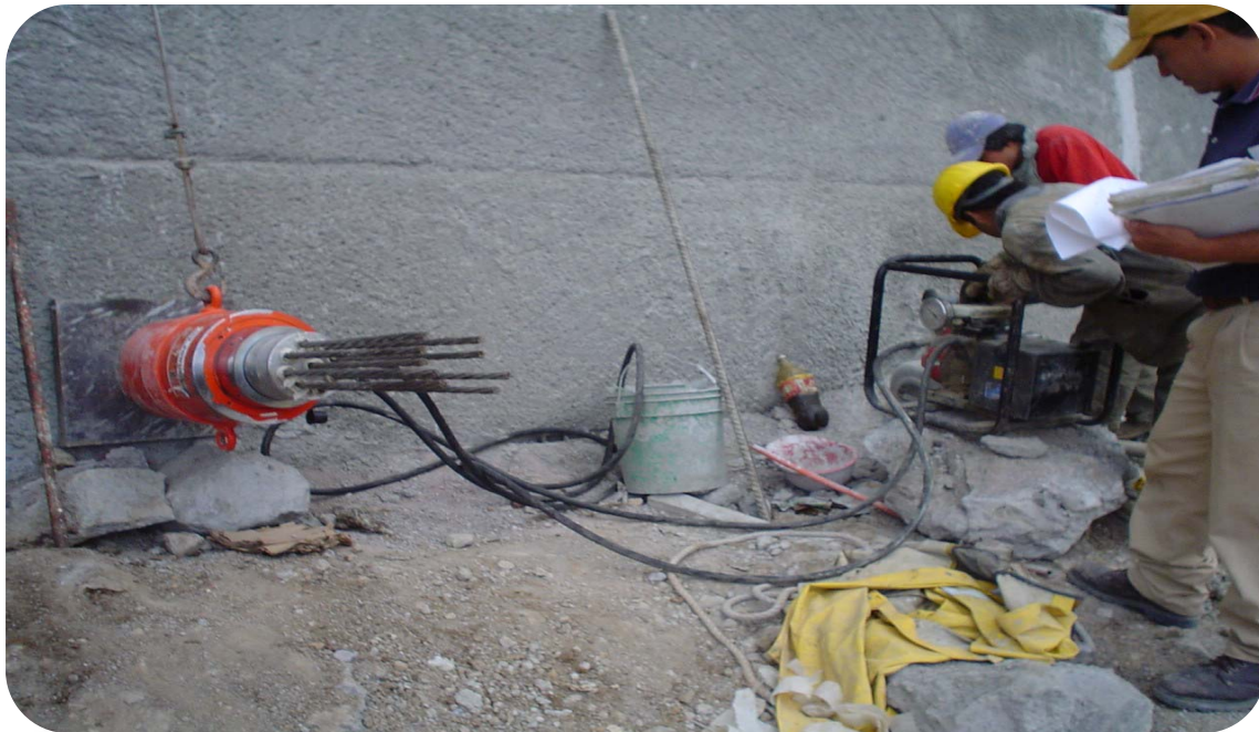
Figura 15. Gato hidráulico durante prueba de carga en un ancla
