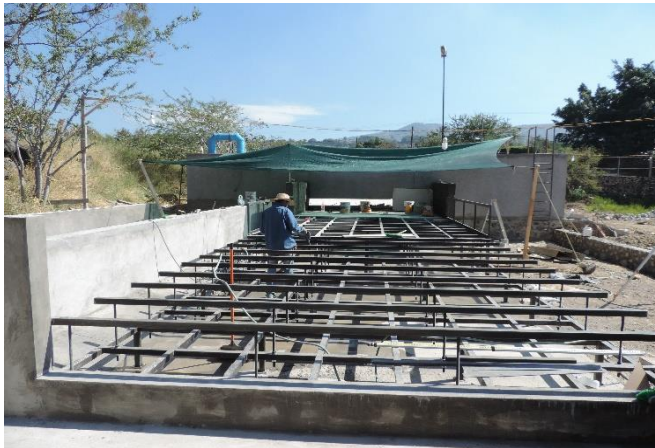
Figura 4-82 Trabajos de soldadura en estructura metálica
