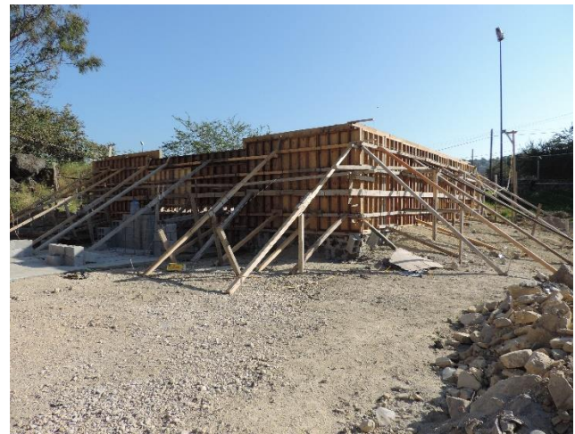
Figura 4-77 Cimbrado final del tanque de almacenamiento
