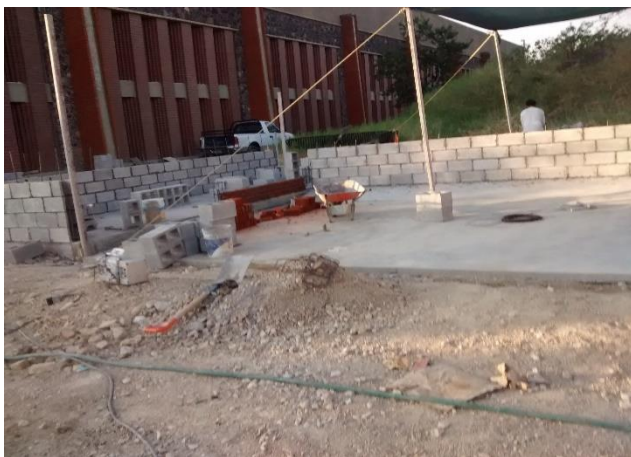
Figura 4-80 Construcción de muros de block y tabique recocado
