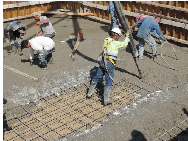
Figura 4-79 Colado del tanque de almacenamiento con ayuda de pluma para vaciado de concreto
