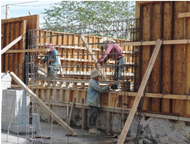
Figura 4-76 Detalle en armado de compuerta
