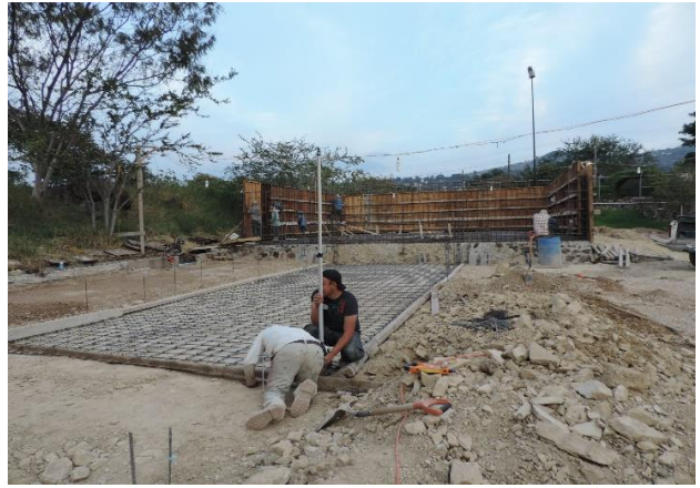
Figura 4-78 Firme de concreto para dar estabilidad a la calle de pendiente variable
