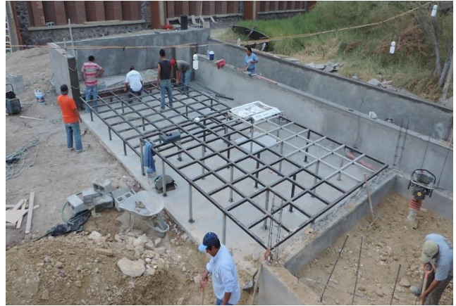
Figura 4-81 Armado y colocación de estructura metálica
