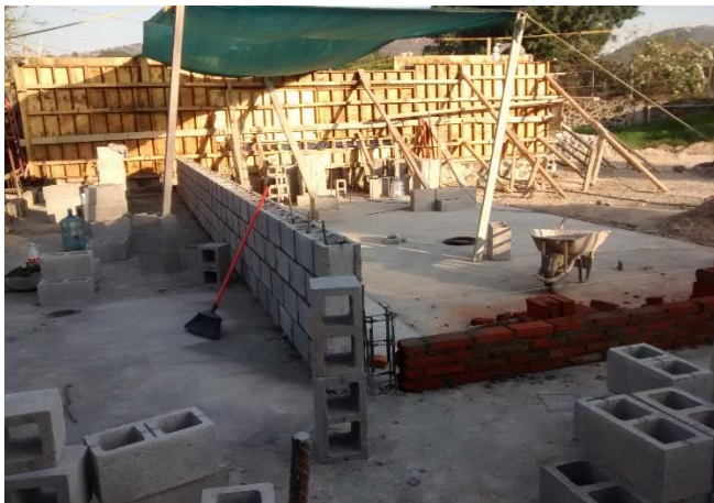
Figura 4-80 Construcción de muros de block y tabique recocado
