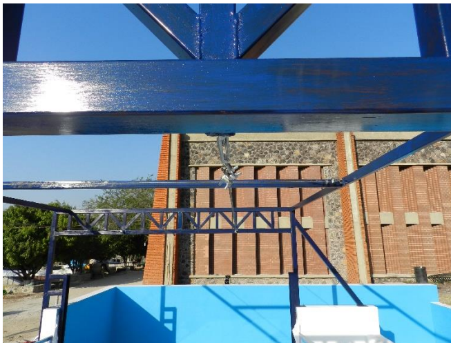
Figura 4-92 Cable de acero en posición longitudinal a la calle con pendiente variable
