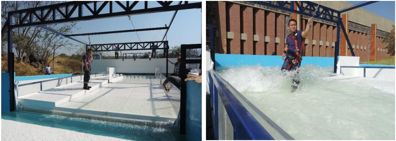
Figura 4-95 Primer prueba para revisión de equipo de seguridad en módulo físico experimental
