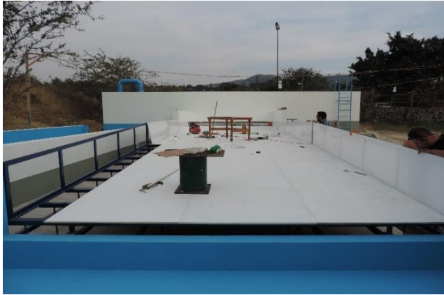
Figura 4-83 Colocación de acrílico en las paredes del módulo y maquinaria de compuerta
