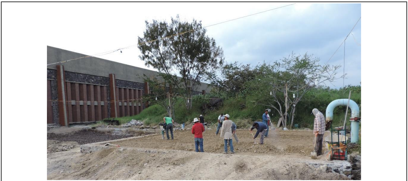
Figura 4-74 Nivelación y compactación del terreno
