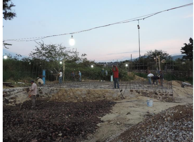
Figura 4-75 Armado de varilla sobre firme de mampostería
