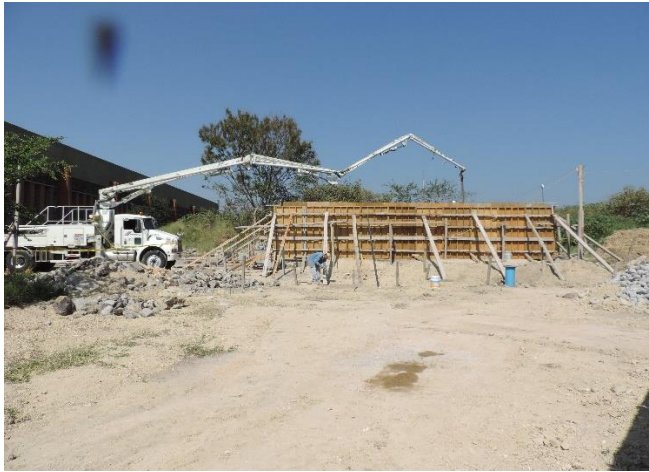
Figura 4-79 Colado del tanque de almacenamiento con ayuda de pluma para vaciado de concreto
