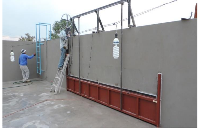
Figura 4-83 Colocación de acrílico en las paredes del módulo y maquinaria de compuerta
