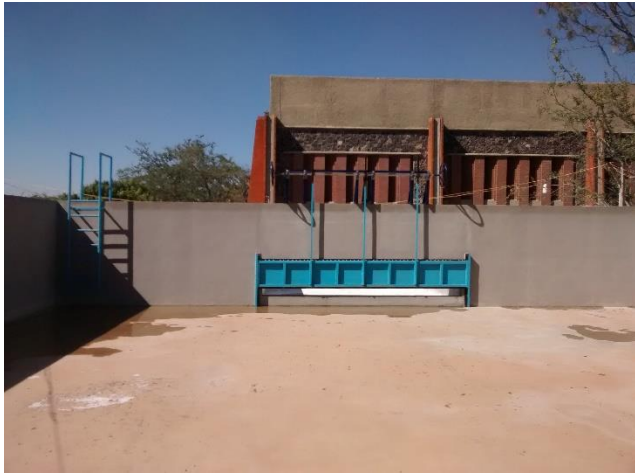
Figura 4-84 Compuerta y tubería de llenado del tanque de almacenamiento
