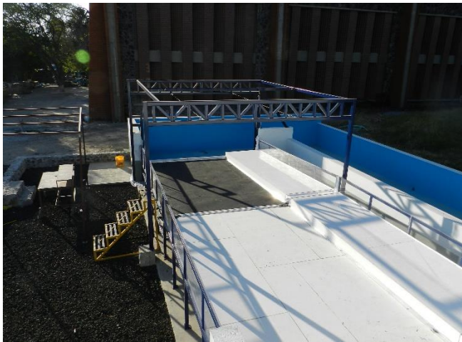
Figura 4-90 Vista de estructura metálica de seguridad
