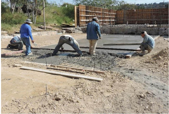
Figura 4-78 Firme de concreto para dar estabilidad a la calle de pendiente variable
