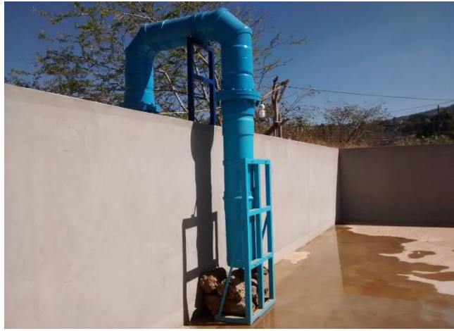
Figura 4-84 Compuerta y tubería de llenado del tanque de almacenamiento
