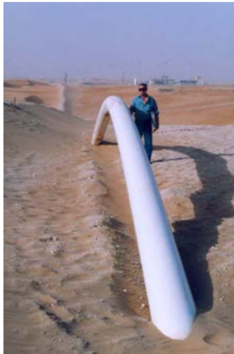
FIGURA 0-3 Ejemplo de pandeo global de un ducto en tierra [41] .
