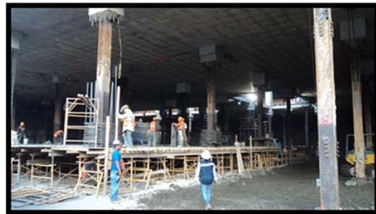
**Ilustración 59. Armado y cimbrado de sótano dos.**
