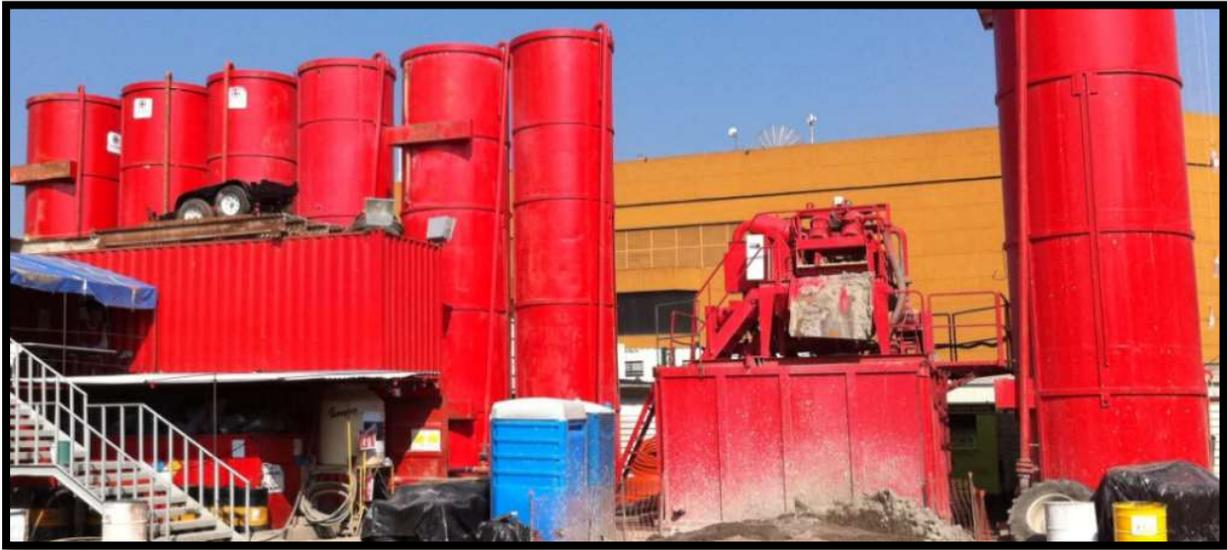
**Ilustración 27. Central de lodos en el proyecto Mítikah.**
