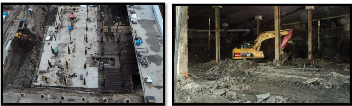
Ilustración 55. Excavación y construcción de losas.
