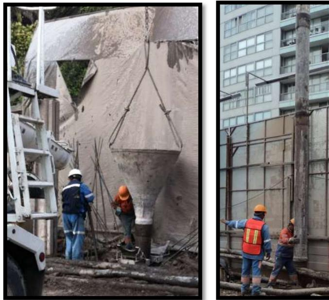
Ilustración 31. Colado con tubería tremi del muro Milán.
