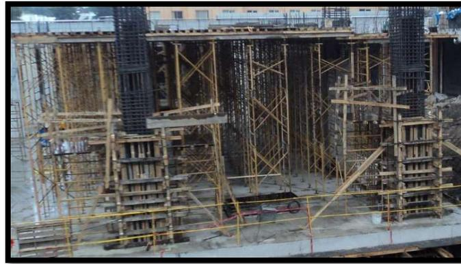
**Ilustración 62. Armado y cimbrado de columnas.**
