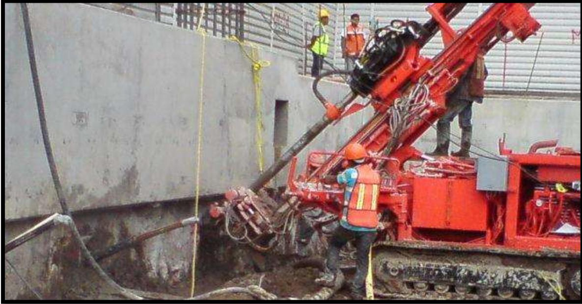
**Ilustración 47. Perforación de anclas.**
