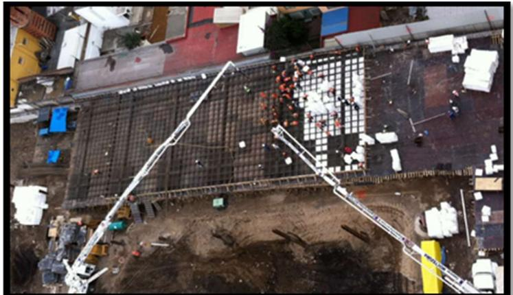
**Ilustración 52. Colado de Planta Baja.**
