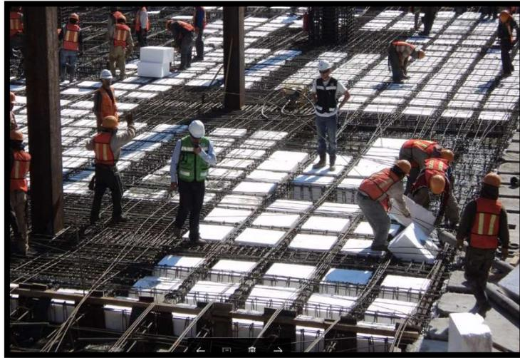
Ilustración 60. Colado de losa con nervadura.
