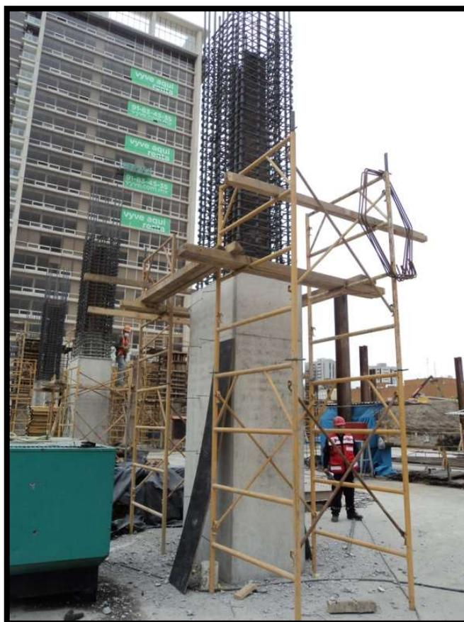
Ilustración 68. Colado de columnas.
