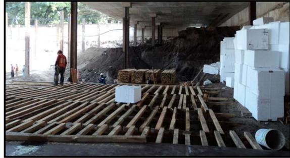
Ilustración 56. Cimbrado de la losa de los sótanos.
