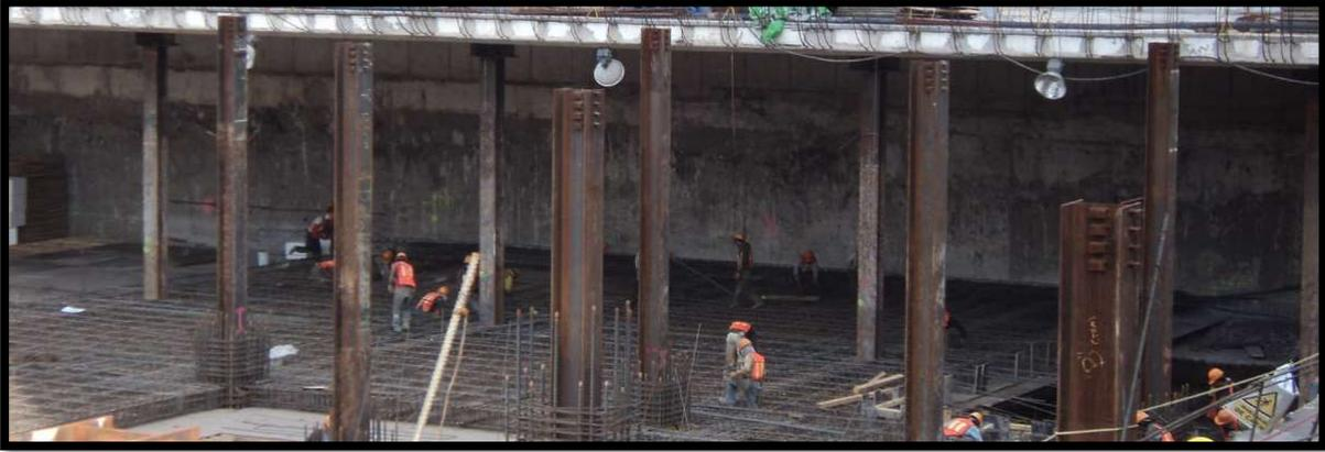
**Ilustración 58. Armado sótano comercial.**
