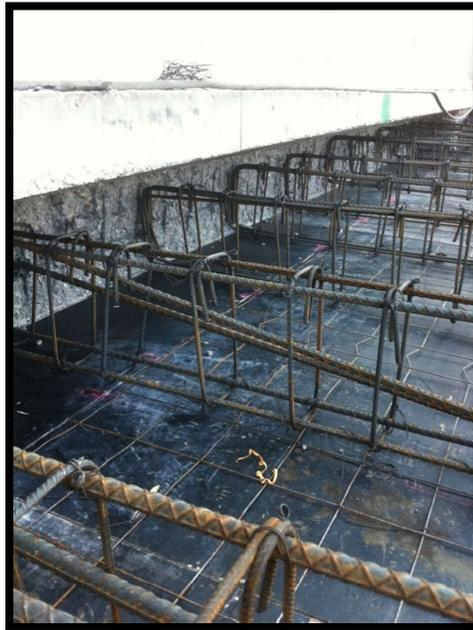
Ilustración 66. Anclaje de losa de planta baja a trabe de coronamiento.
