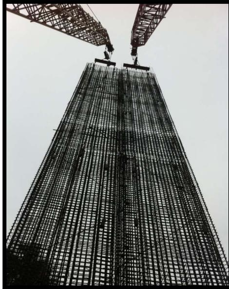
**Ilustración 29. Izaje de dos paneles del muro Milán.**
