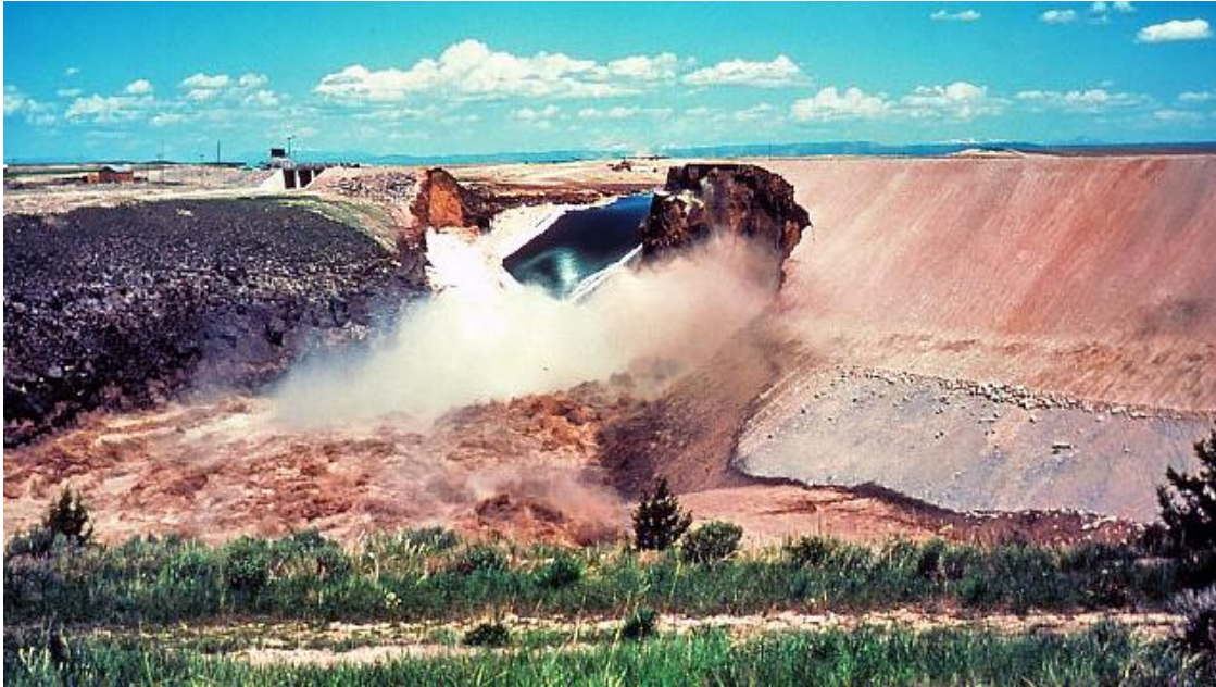
Figura 1.28 Vista del rompimiento de la presa Teton en Junio de 1976. Department of Earth Science, University of California (1976).
