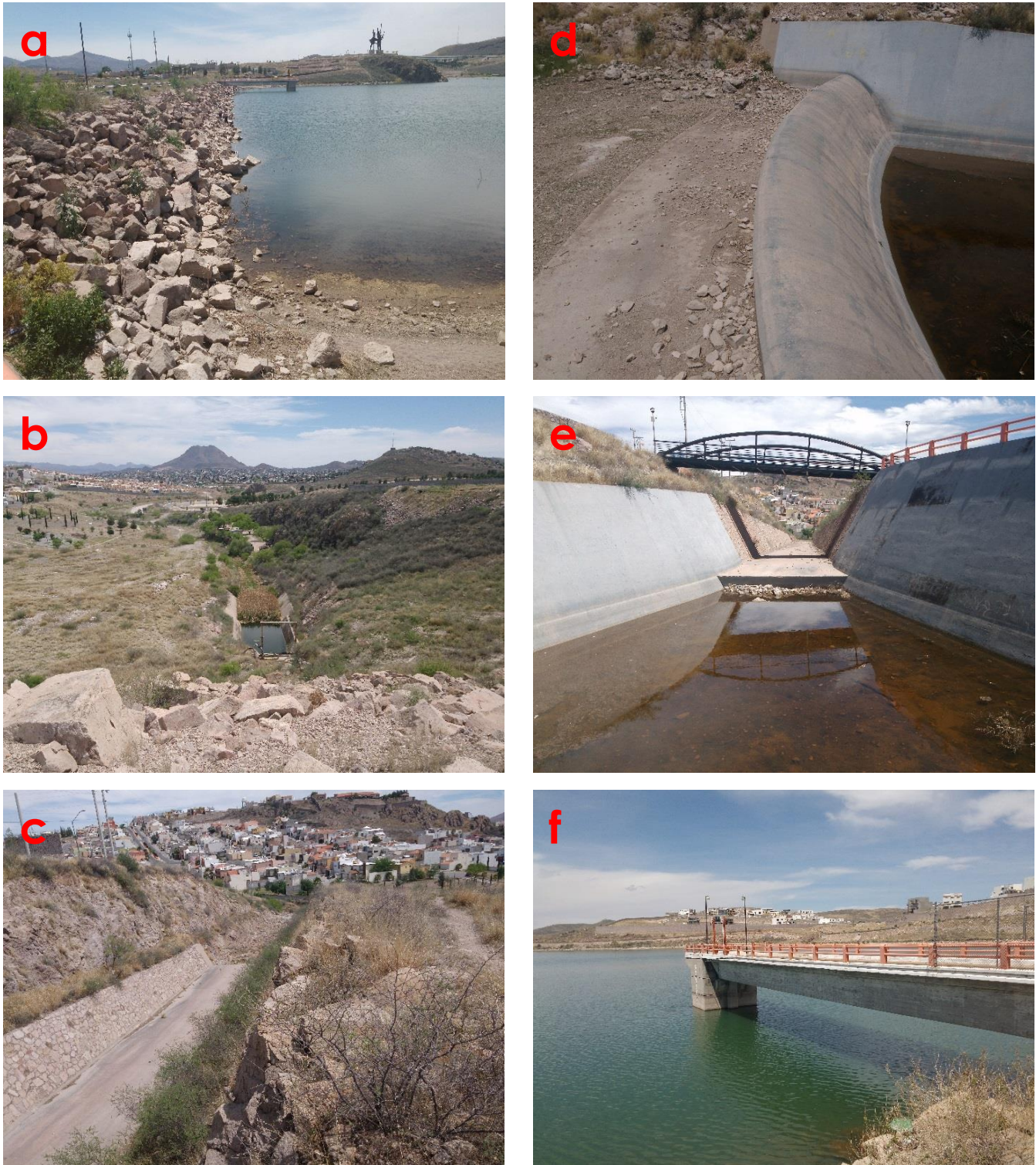
Figura 5.2 Fotografías de algunos elementos de la presa El Rejón. a) Paramento aguas arriba de la cortina. b) Vista aguas abajo de la cortina y obra de toma. c) Canal de salida. d) Vertedor cimacio curvo. e) Estanque amortiguador. f) Torre limnómetro y válvulas de obra de toma.
