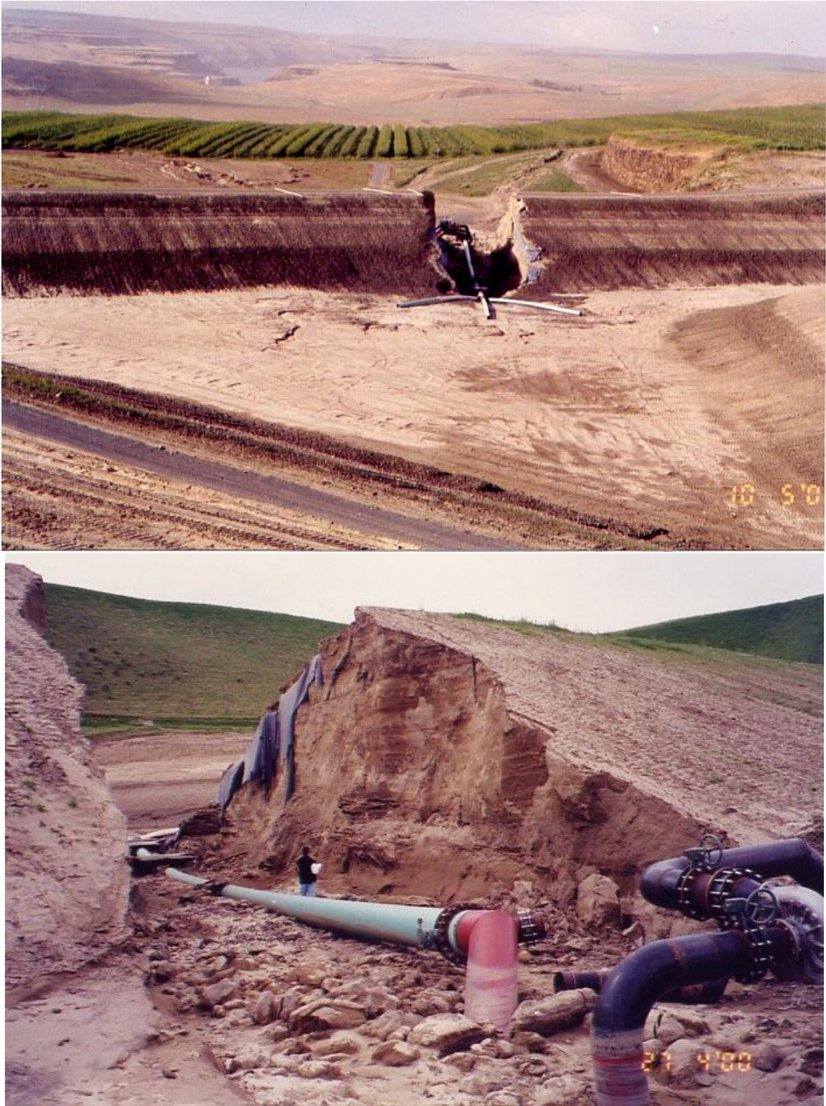
Figura 1.30 Falla de presa por tubificación en Walla Walla County. Washington State Department of Ecology (1993).
