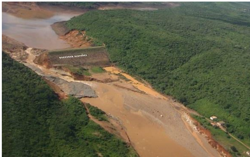
Figura 1.29 Vista del rompimiento del dique de Minas Gerais en Mariana, Brasil. Globo News (2015).
