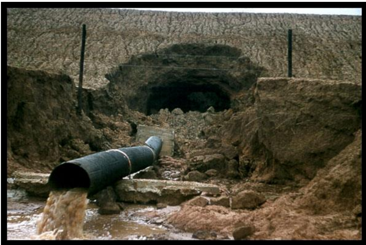
Figura 1.24 Falla por tubificación en una presa de Ohio. U.S. Department of Agriculture (2012).
