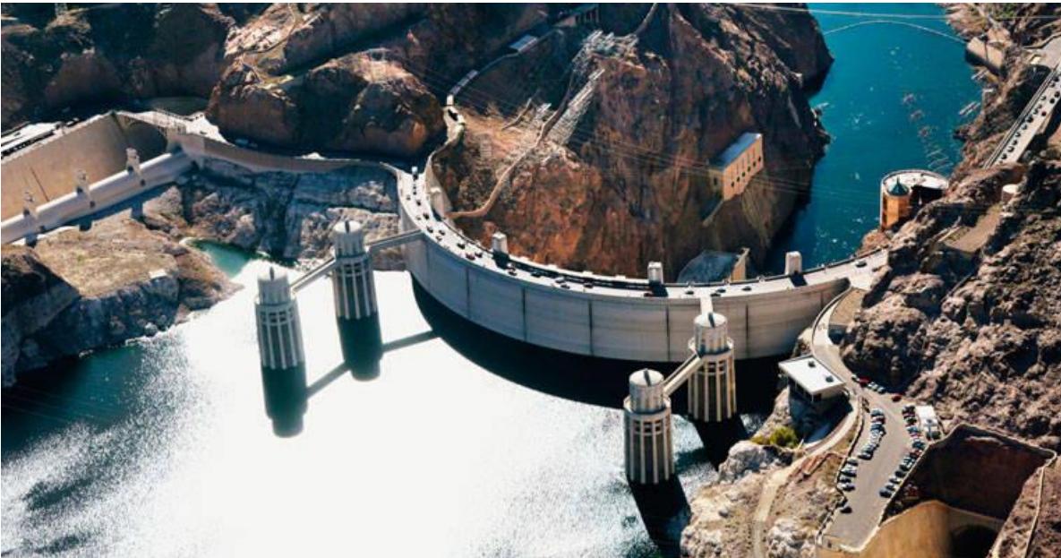
Figura 1.2 Presa Hoover tipo arco-gravedad. (2006).
