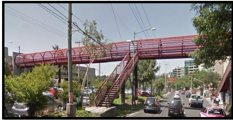
Figura 2.13 Ejemplo de puente peatonal en Picacho Ajusco. Fuente: Google Maps.
