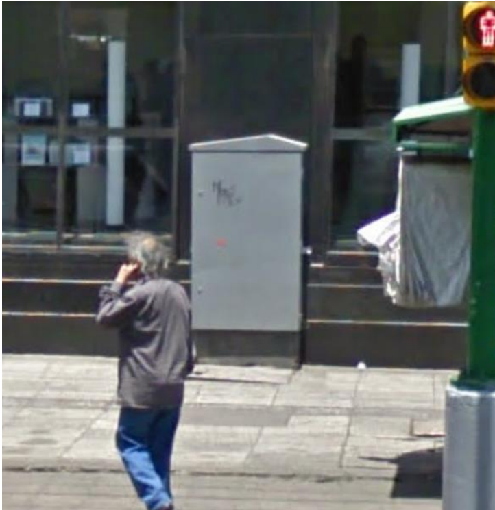
UNIDAD DE CONTROL
