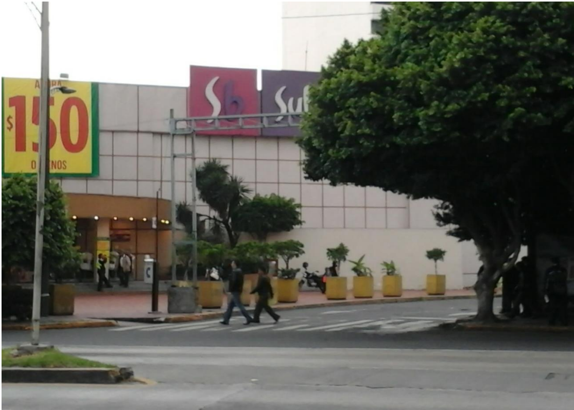
Acceso H. Av. California
