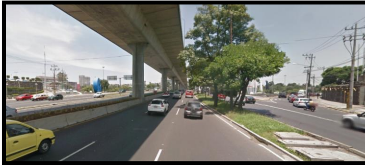
Figura 2.7 Ejemplo de vía Anular, Periférico Sur. Fuente: Google Maps.
