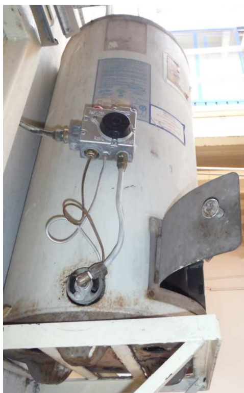
Ilustración 32 – Calentador de agua de deposito.
