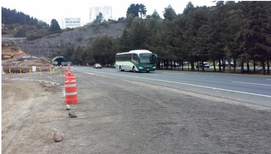
Imagen 1: Entrada a la Rampa de Frenado de Emergencia
