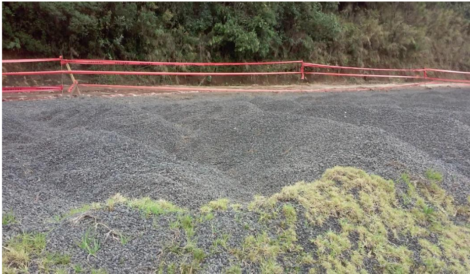
Imagen 5: Cama de Frenado de la Rampa de Emergencia
