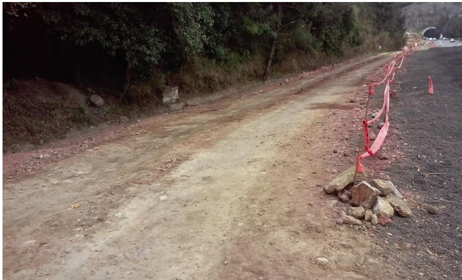
Imagen 9: Final del Camino de Servicio
