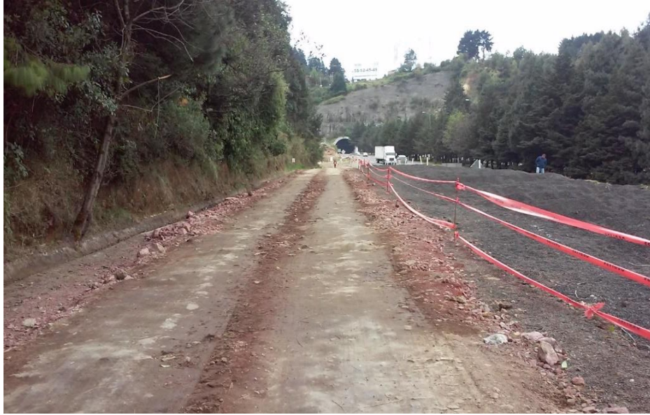
Imagen 6: Camino de Servicio de la Rampa de Emergencia
