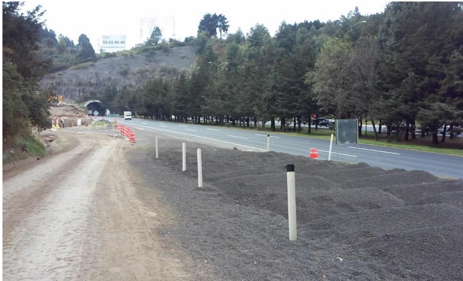
Imagen 7: Camino de Servicio de la Rampa de Emergencia
