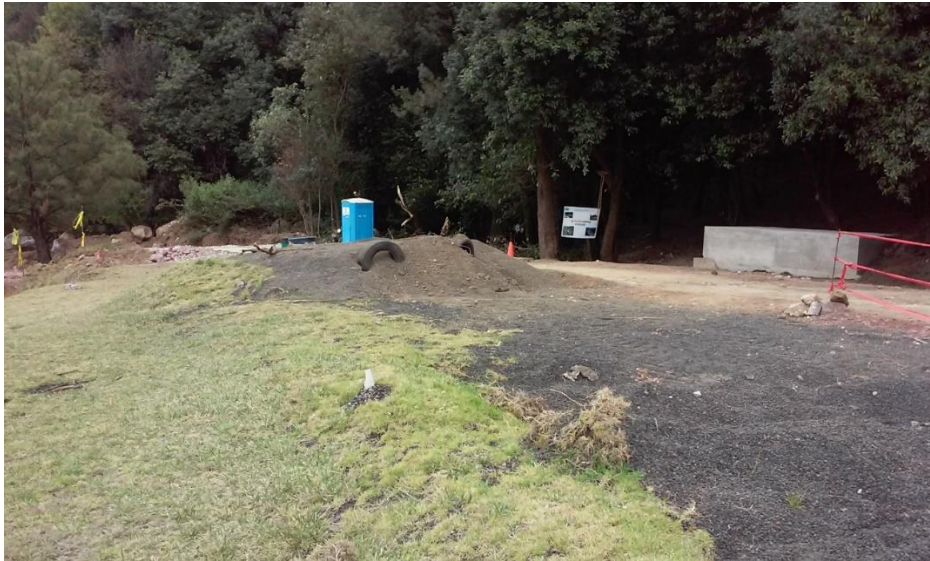
Imagen 10: Final de la Cama de Frenado de la Rampa de Emergencia
