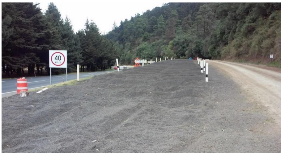
Imagen 3: Entrada a la cama de frenado
