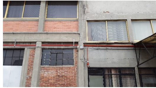
Fotografía 19 Canalización del primer piso
