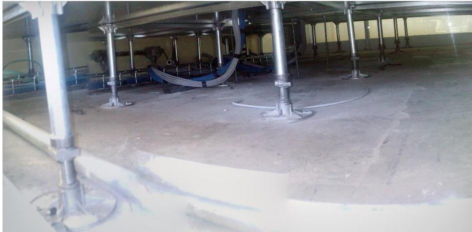
Fotografía 1 Instalación de piso falso
