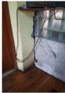
Fotografía 12 Edificio 1, Primer Piso. Intersección entre edificios
