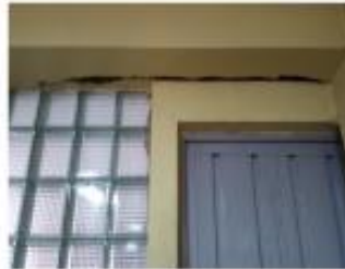
Fotografía 13 Edificio 1, Primer Piso. Intersección entre edificios
