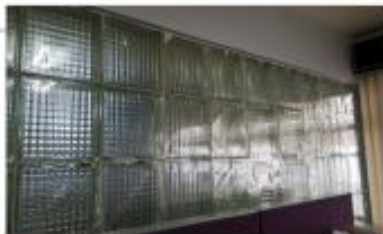
Fotografía 4 Edificio 2, Planta Baja. Intersección entre edificios
