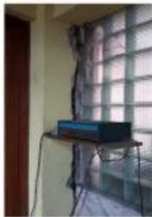
Fotografía 11 Edificio 1, Primer Piso. Intersección entre edificios
