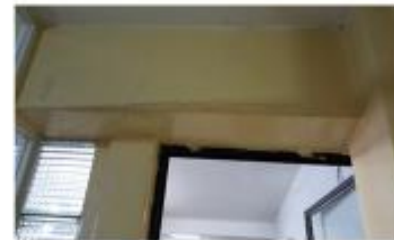
Fotografía 3 Edificio 1, Planta Baja. Intersección entre edificios
