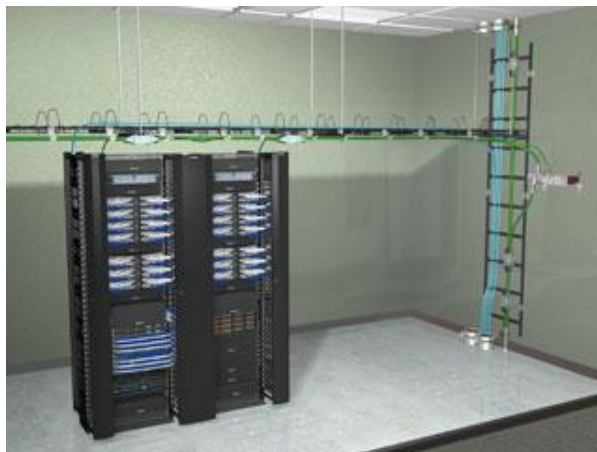
Figura 24 Ejemplo de Sala de Telecomunicaciones 11
