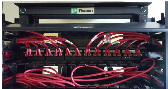
Fotografía 21 Patch panel vista frontal
