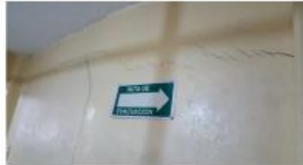
Fotografía 2 Edificio 1, Planta Baja. Colindancia con la Escuela.
