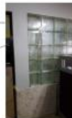
Fotografía 5 Edificio 2, Planta Baja.
