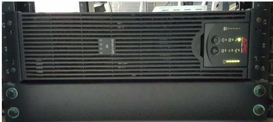
Fotografía 6 Colocación de UPS en el rack
