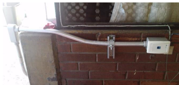
Fotografía 27 Nodo de voz externo, para el área de vigilancia
