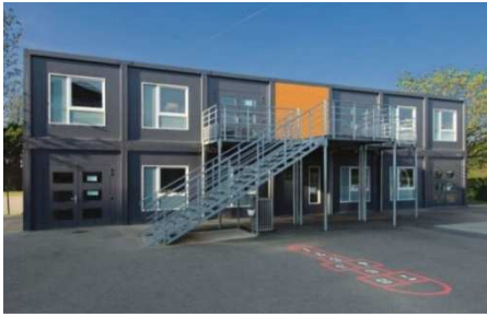
Figura 63. Aulas prefabricadas provisionales para colegio 120
