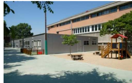
Figura 66. Construcción modular para ampliación de colegio destinada a guardería. 123
