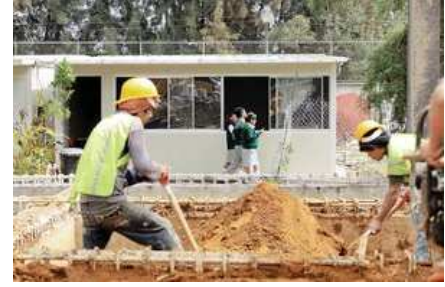
Figura 19. Construcción de aulas modulares en el D.F. 48
