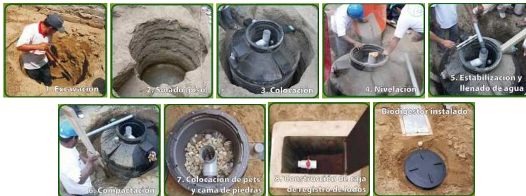
Figura 34. Proceso Constructivo de un biodigestor 79
