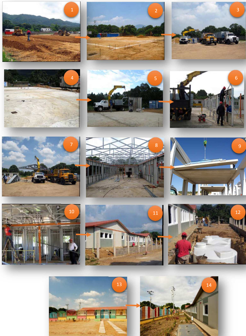
Figura 36. Proceso constructivo general de una EMS 81
