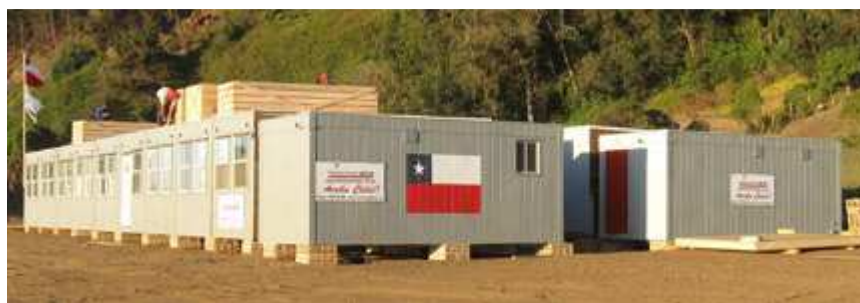
Figura 15. Módulos escolares en Chile colocados y en funcionamiento 39
