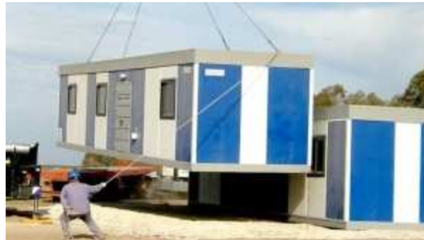
Figura 57. Colocación de módulos en República de Argentina 111
