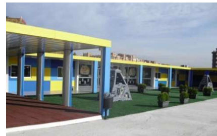
Figura 68. Colegio realizado en construcción modular 125
