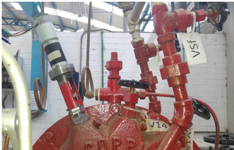
Ilustración 76 instalación de válvula
