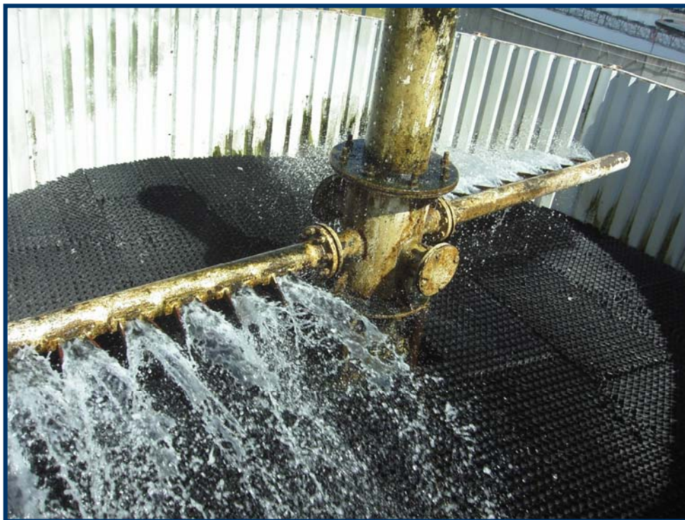
Figura No. 38. Medio filtrante compacto y brazo rotatorio. Fuente del autor.
