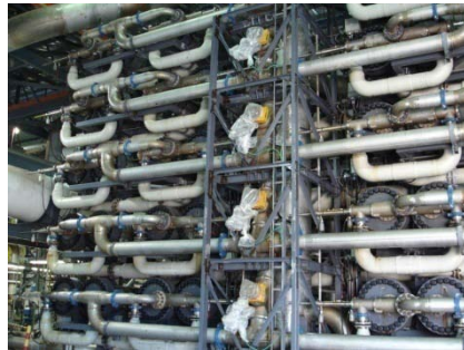
Figura 13: Recuperadores de energía (Cortesía Planta Askelon)
