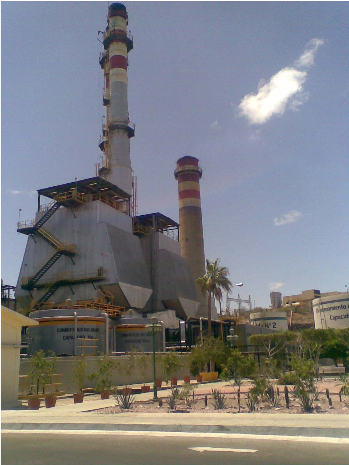
Figura 2: Planta Termoeléctrica Punta Prieta - Pichilingue
