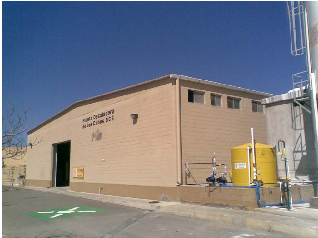
Figura 5: Planta desaladora "Los Cabos B.C.S." del grupo INIMA
