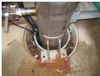
Figura 3: Pozo playero, planta desaladora Los Cabos, cortesía Grupo INIMA Desalación
