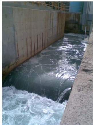
Figura 7: Canal de llamada de planta termoeléctrica
