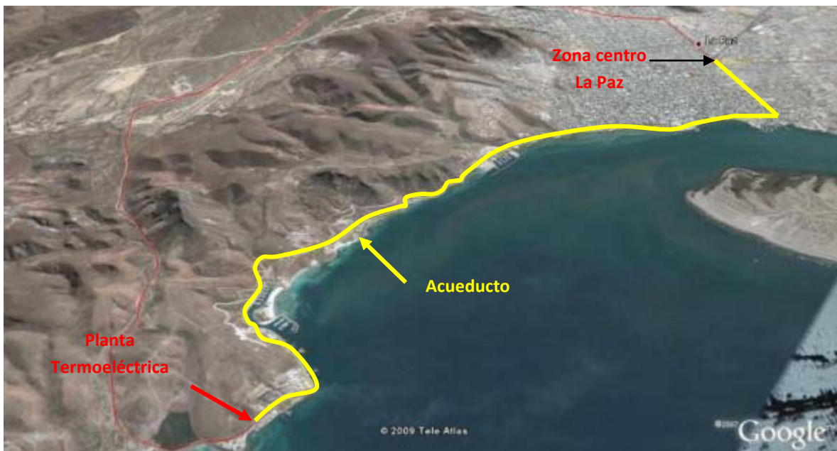
Figura 5: Acueducto para el transporte del agua producto de Planta Termoeléctrica a La Paz
