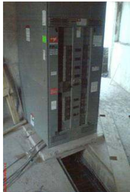
Montaje de Tablero Principal Subestación Eléctrica
