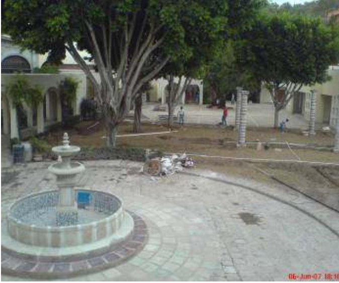
Colocación de azulejo a fuente y construcción de riego en jardín columnas
