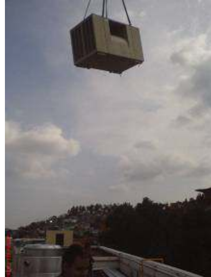
Montaje de Equipo de Aire Lavado
