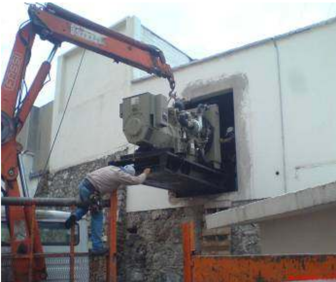
Montaje de Equipo de Aire Lavado
