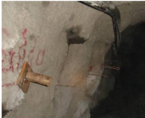
37:Figura No. VIII. 14. Preparación de anclas
