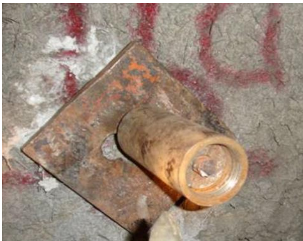
41:Figura No. VIII. 18. Mordazas y porta-mordazas instalados correctamente
