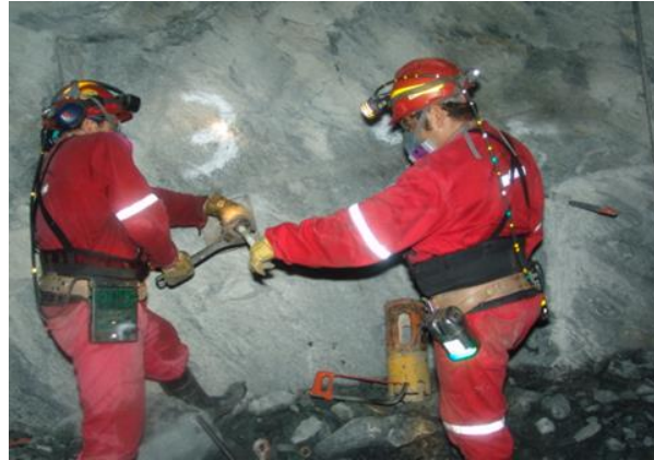
42:Figura No. VIII. 19. Instalación y ajuste de espárrago en porta-mordazas
