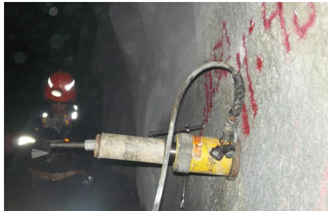
43:Figura No. VIII. 20. Instalación de cilindro hidráulico, de capacidad de 30 toneladas
