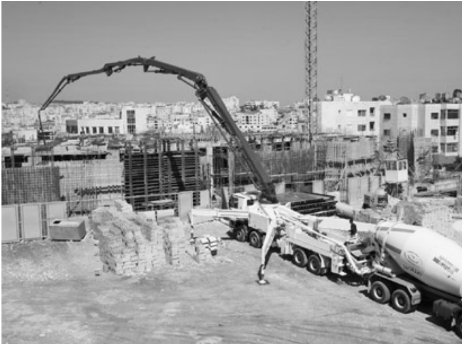
Figura 4. Equipo de bombeo de concreto hidráulico en la construcción de viviendas.
