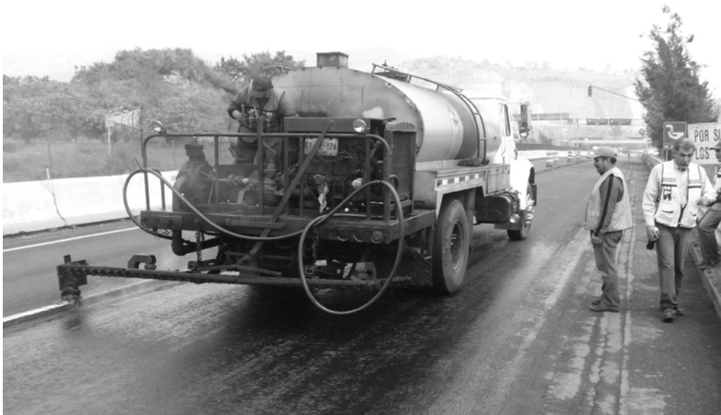
Figura 82. Riego del material con equipo.
