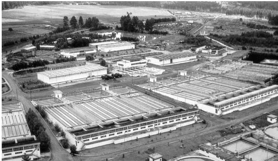
Fuente: CONAGUA. Modernización sistema de filtración ETAP Los Berros.
