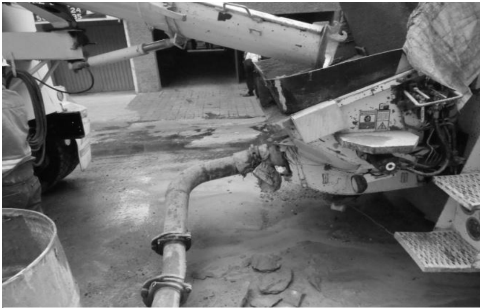
Figura 70. Conexión de tubería en el suministro del concreto.
