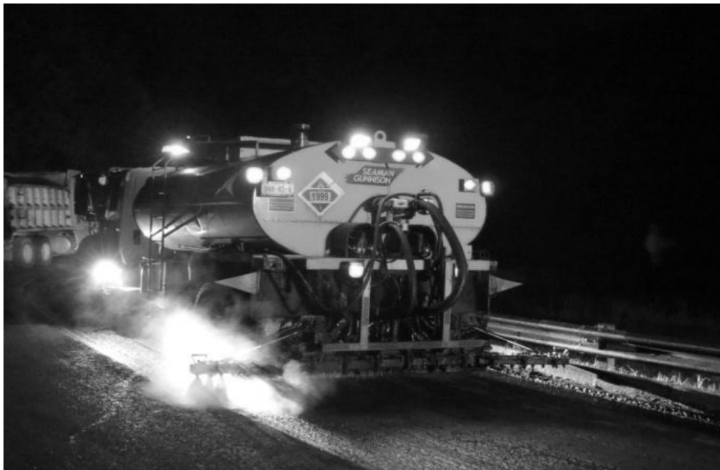
Figura 84. Riego del material con otro modelo de petrolizadora.
