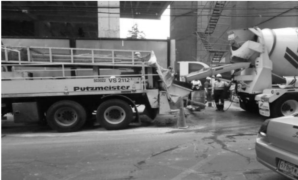
Figura 68. Suministro de concreto premezclado al autobomba.
