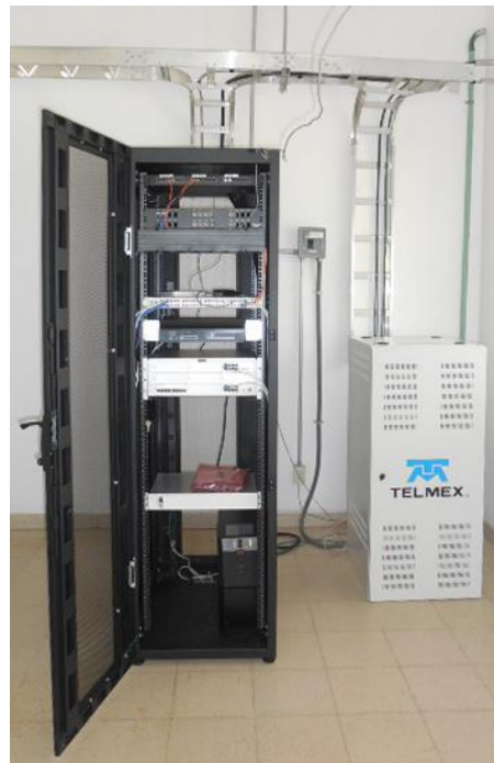
Figura 3.10 SITE sin techo ni piso falso (fuente: fotografía tomada por el autor).
