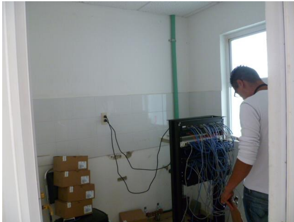
Figura 3.22 Fotografía de IDF en las oficinas de Uruapan en Michoacán (Fuente: Fotografía tomada por el autor).
