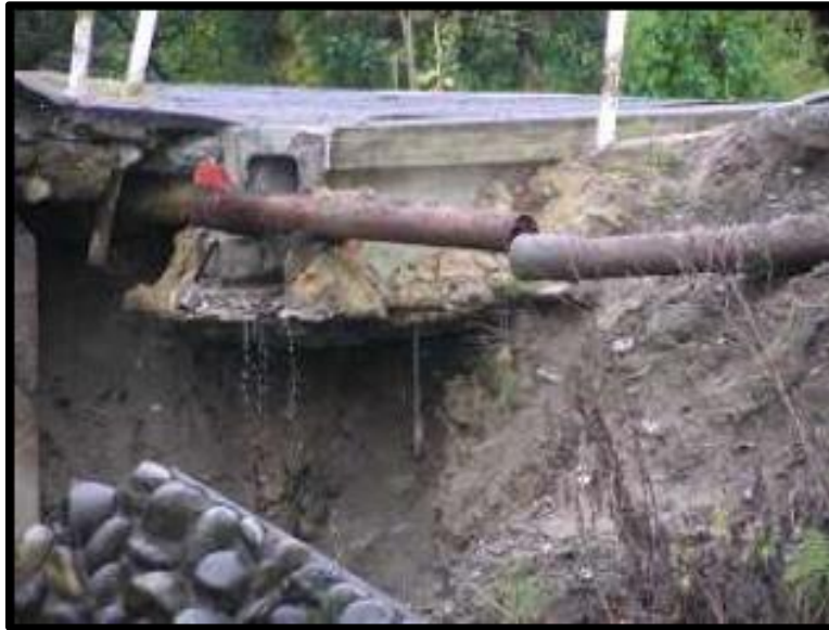
Figura 11. Desconexión de tuberías (Javanbarg 2008)
