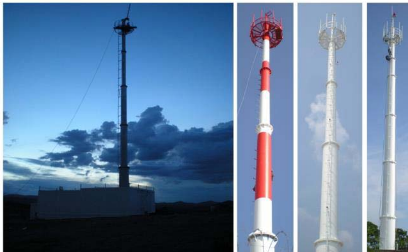
Figura 7.18 Torre tipo monopolo.
