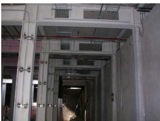
Figura 1.5 Canalizaciones Teatro Tel Cel, CDMX.
