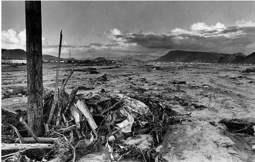
Figura 11.- Daños causados por la inundación debido a la falla del bordo en el arroyo El Cajoncito, Baja California Sur, 2 de octubre de 1976. (Fuente: Patt Morrison 1976, Hurricane Liza devastates La Paz. Los Angeles Times).
