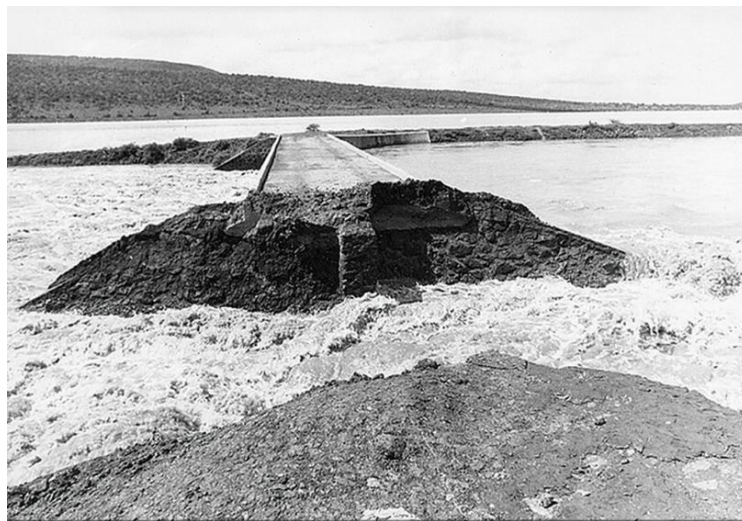
Figura 7.- Imagen de la presa El Conejo, en el instante de la falla. (Fuente: EXCELSIOR, 2013).
