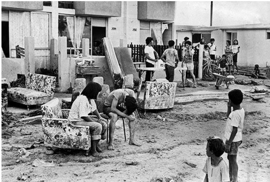
Figura 13.- Personas afectadas afuera de sus casas con diversos daños debido a la presencia del huracán Liza, en Baja California Sur, La Paz, 2 de octubre de 1976. (Fuente: Patt Morrison 1976, Hurricane Liza devastates La Paz. Los Ángeles Times).
