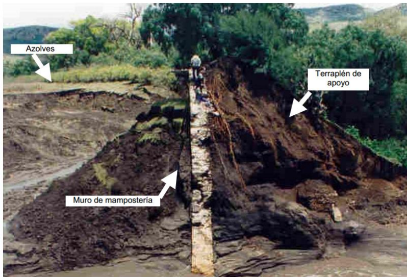
Figura 18.- Muro de mampostería y terraplén de apoyo en el paramento aguas abajo de la cortina.
