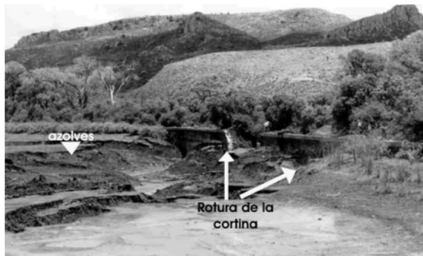
Figura 17.- Falla de la presa El Capulín. Vista de los azolves. (Fuente: http://www.proteccioncivil.gob.mx ).
