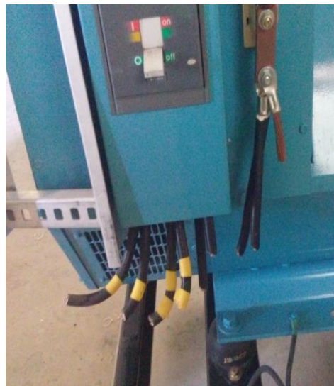
Figuras 83 a 87. Algunos ejemplos de cómo deshabilitaban los equipos para robarse el cable. Fotos de mi autoría.
