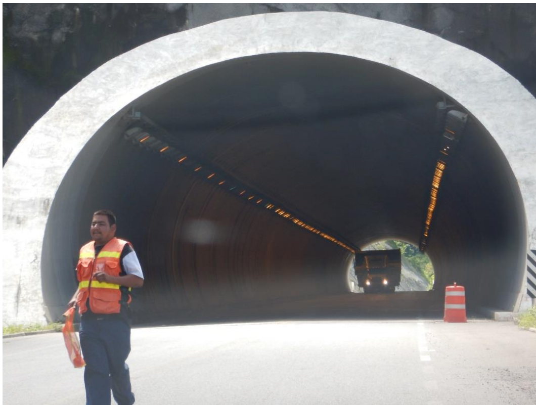
Figura 10. Túnel convencional visto de frente, al interior del túnel solo se cuenta con luminaria y vialetas. Foto de mi
