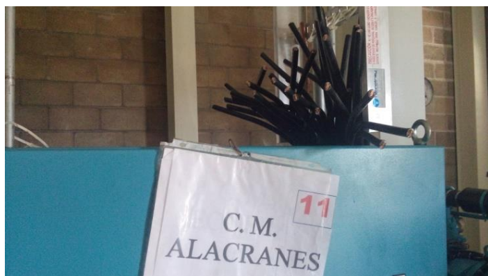
Figuras 83 a 87. Algunos ejemplos de cómo deshabilitaban los equipos para robarse el cable. Fotos de mi autoría.
