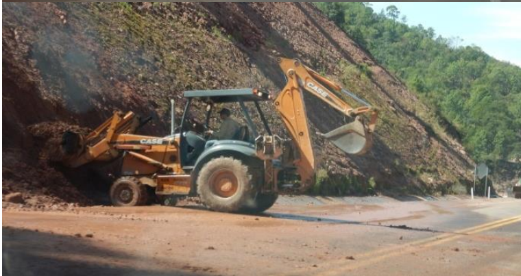
Figura 64 y 65. Hacia la parte alta de la sierra del lado de Durango, la geología cambia, aquí nos encontramos con materiales más sueltos como limos arcillosos y arenas limosas muy sueltas, igual que con los materiales rocosos, se retira el material que invade la calzada. Este talud es muy peculiar, ya que por el alto contenido de humedad, se tiene que limpiar todos los días. Fotos de mi autoría.
