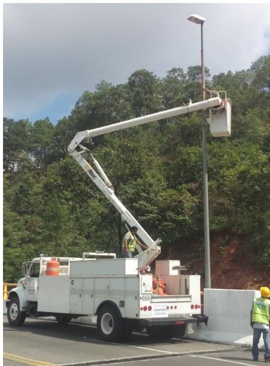
Figura 29 y 30 Pintamos estos postes con una periodicidad de cada 18 meses para contrarrestar los efectos de la corrosión e intemperie.
