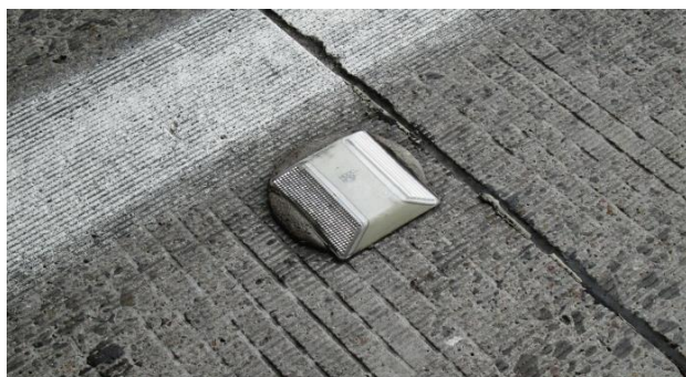
Figura 22. Vialeta blanca marca SWARFLEX con cristales reflectantes Sobre línea discontinua blanca para separar el carril de circulación del acotamiento.
