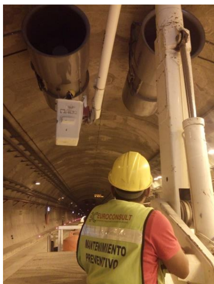
Figuras 32 y 33. Turbinas de ventilación
