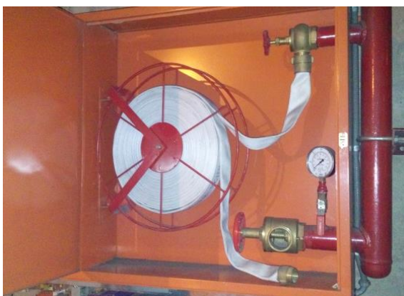
Figuras 52 y 53. Tableros de emergencia, la comunicación con el centro de control se revisa una vez por semana, la presión de las mangueras se checa cada mes, se da limpieza y se extiende la manguera para asegurarnos que saldrá bien en caso de incendio. Fotos de mi autoría.
