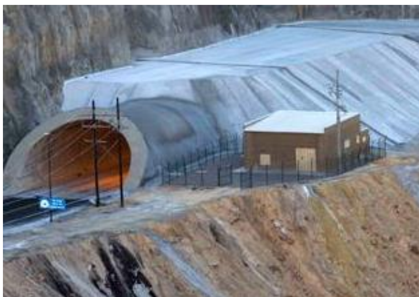
Figura 11. Casa de máquinas al exterior del túnel Carrizo III
