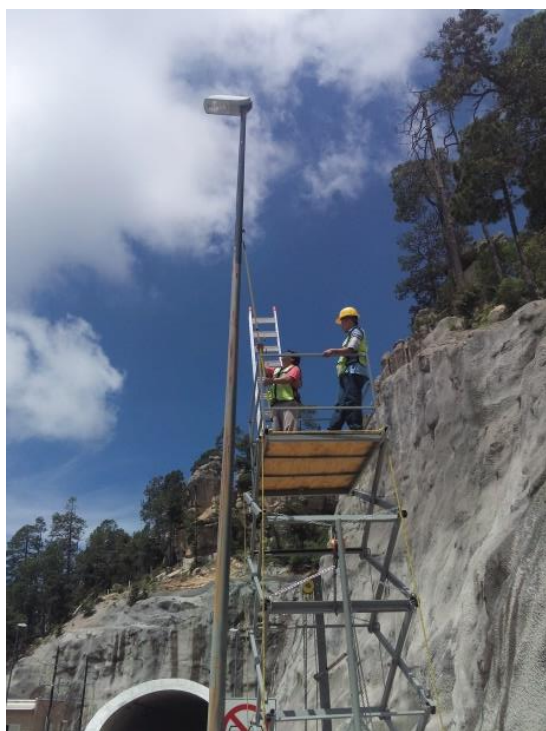
Figura 29 y 30 Pintamos estos postes con una periodicidad de cada 18 meses para contrarrestar los efectos de la corrosión e intemperie.
