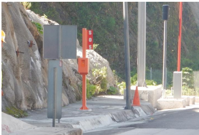
Figura 57. Teléfono de emergencia en la boca del túnel el Sinaloense. Foto de mi autoría.
