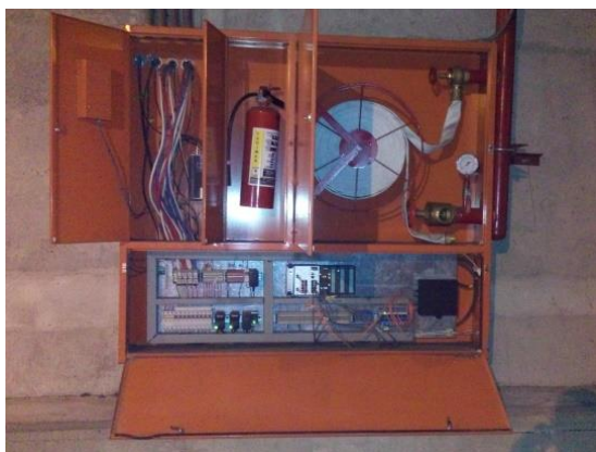
Figuras 52 y 53. Tableros de emergencia, la comunicación con el centro de control se revisa una vez por semana, la presión de las mangueras se checa cada mes, se da limpieza y se extiende la manguera para asegurarnos que saldrá bien en caso de incendio. Fotos de mi autoría.
