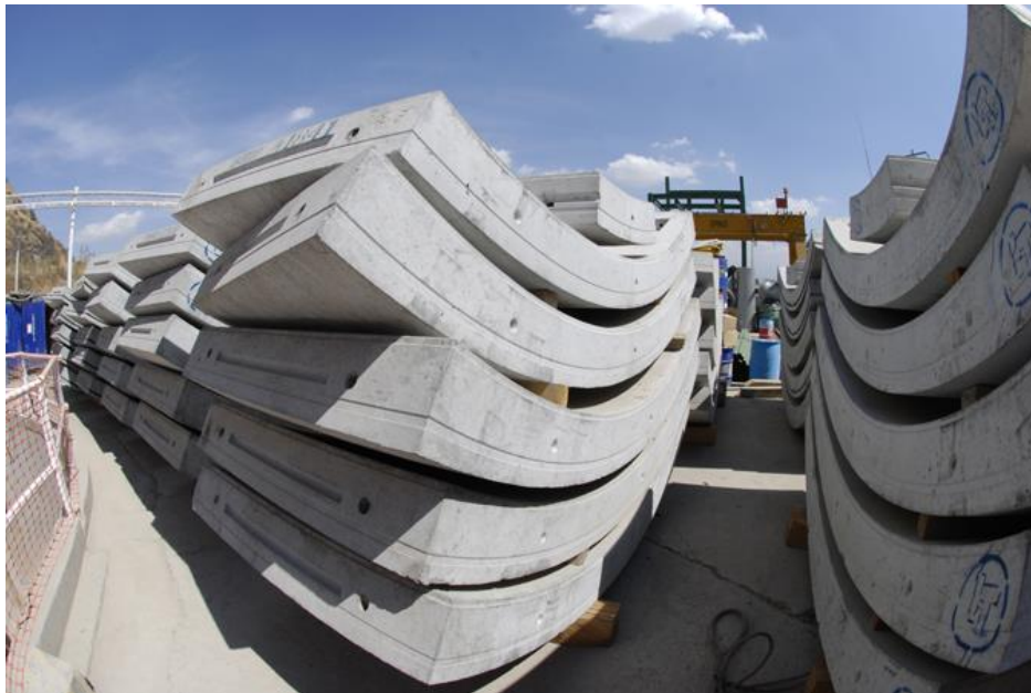
Ilustración 2 Dovelas acomodadas en juego para su colocación.
