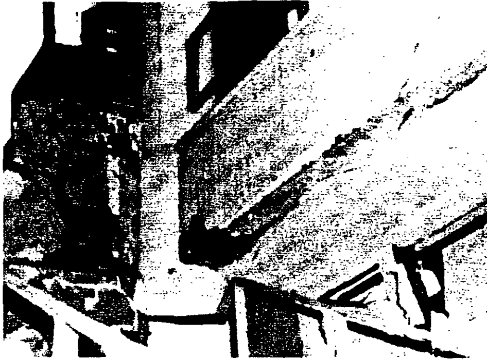
Figura 3.3 Falla por compresión en trabes.
