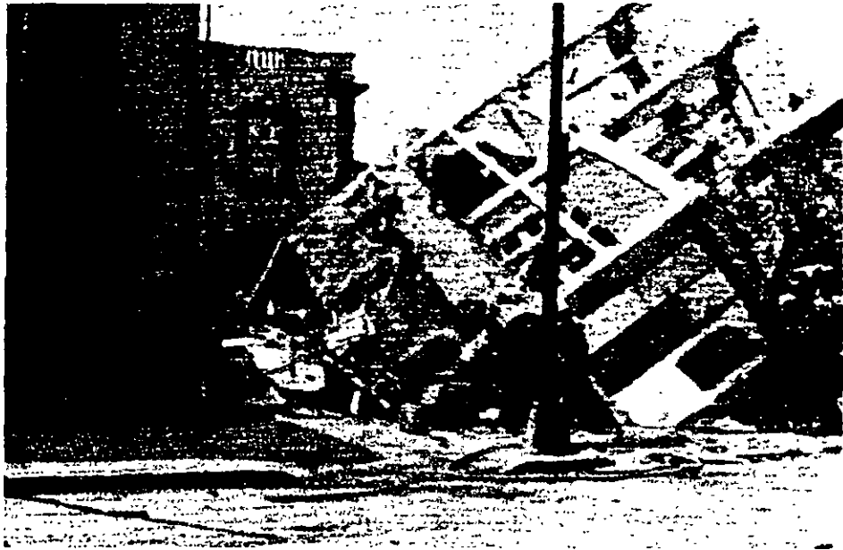
Figura 3.27. Fallas de cimentación.
