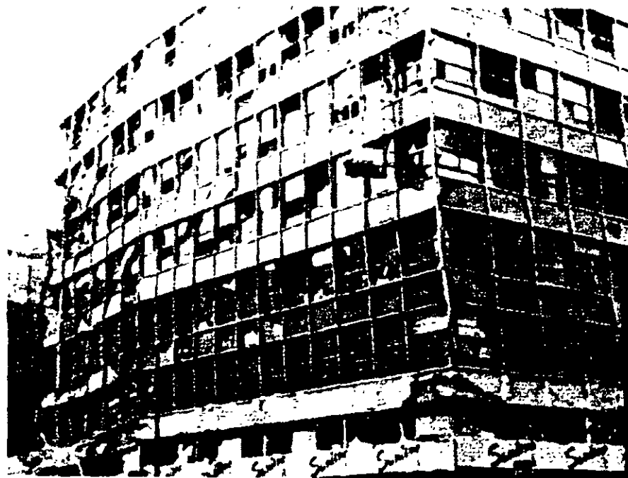
Figura 3.16. Edificios en esquina, dañados por el sismo.
