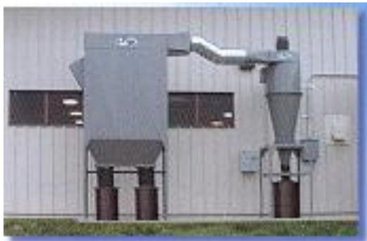
Figura 4.8 Sistema de extracción de gases y un colector de polvos.<sup>68</sup>
