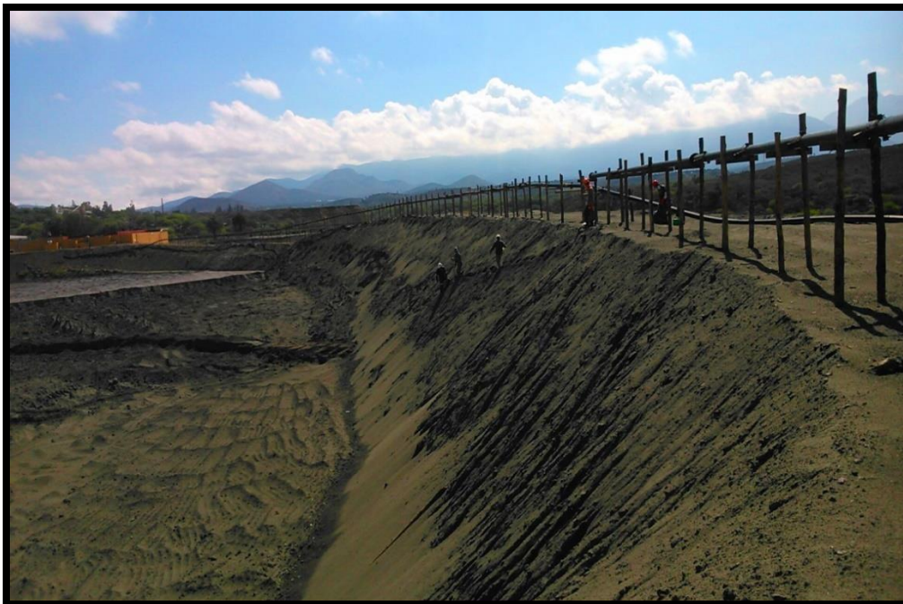
Figura 5.13. Bordo de contención de la presa de jales número 1 de la Compañía Minera y Beneficiadora Purísima.
