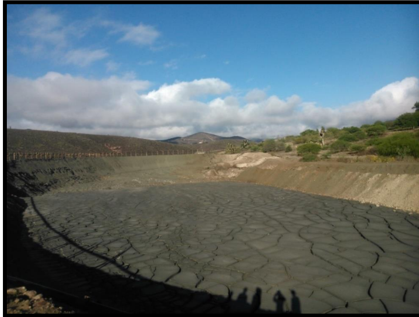
Figura 5.10. Presa de jales número 5 de la Compañía Minera y Beneficiadora Purísima.
