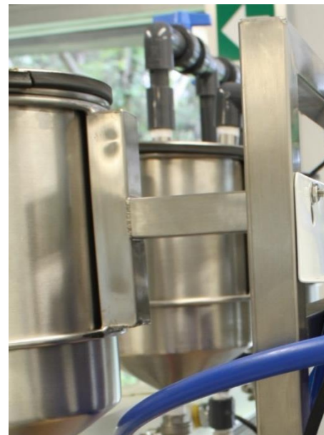
Tanque de recirculación
