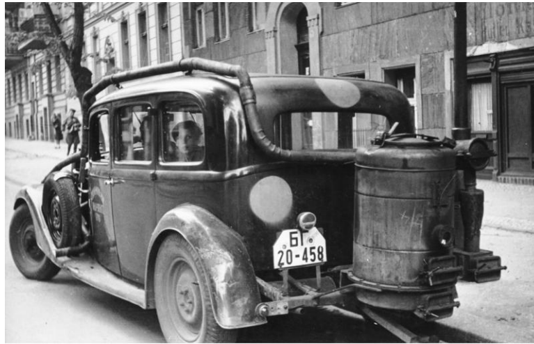
Figura 1.1: Automóvil con gasificador
