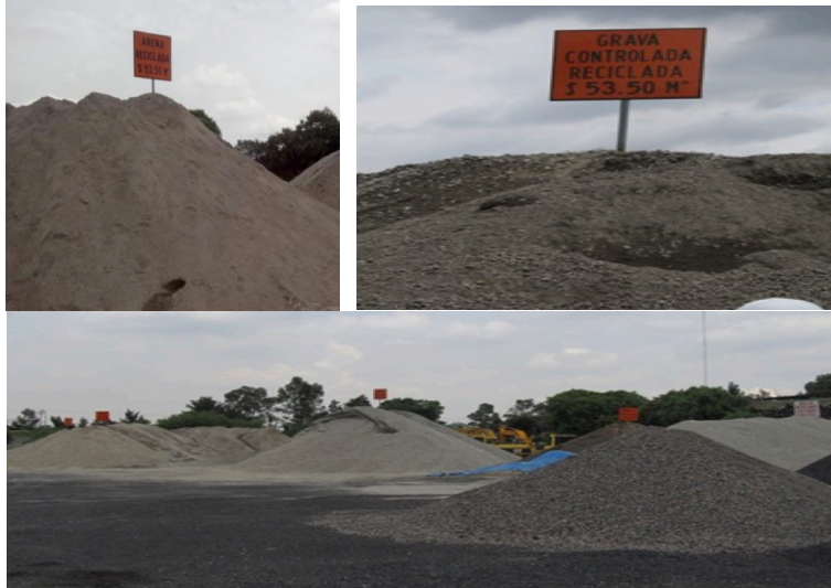
Figura 3.1 Área de almacenamiento de agregados en PCR
