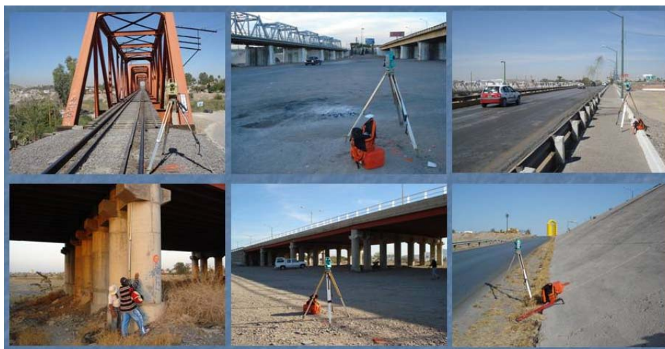
Figura III-17. Levantamiento topográfico en puentes. La poligonal de apoyo levantada permitió referir la topografía de los puentes al mismo banco de nivel considerado en la restitución fotogramétrica y propagar las coordenadas obtenidas con equipos GPS. Zona federal del Río Nazas en Torreón, Coahuila.
