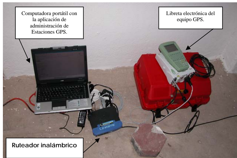
Figura IV-43. Dispositivos necesarios para llevar a cabo las pruebas de comunicación en sitio. Estación de Referencia OCPBC. Mexicali, Baja California.
