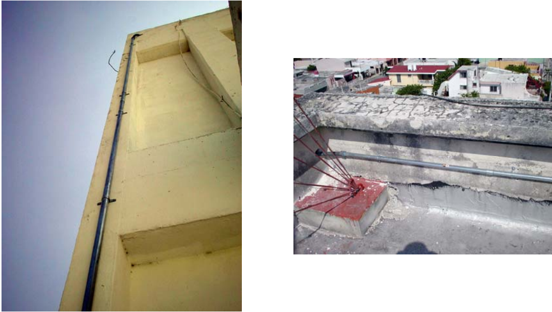
Fig. IV-10. Aspectos de la canalización del cable coaxial de la antena
