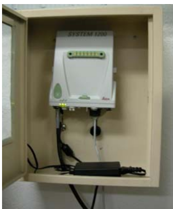
Figura IV-5. Receptor de la Estación de Referencia GPS resguardado en caseta de protección y mástil de la antena libre de obstáculos. Estación GRPY. Mérida, Yucatán.
