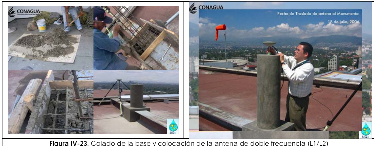
Figura IV-23. Colado de la base y colocación de la antena de doble frecuencia (L1/L2)
