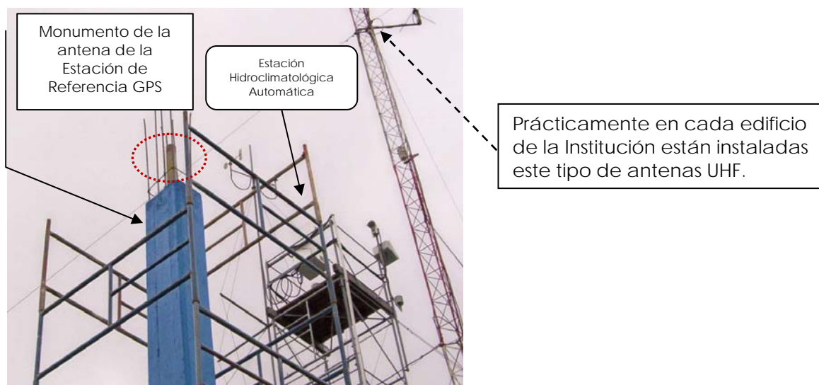
Figura IV-3. Antena de transmisión de radio UHF para atención de emergencias en la Comisión Nacional del Agua. Xalapa, Ver.
