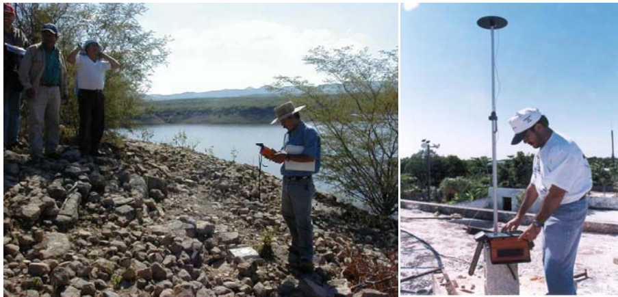
Figura III-12. Levantamiento de puntos de control para el apoyo de brigadas topográficas.
