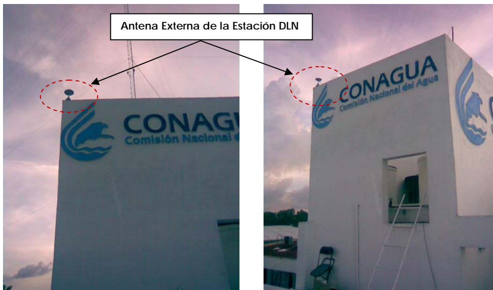
Figura IV-39. Instalación provisional de la Antena Externa de la Estación de Referencia GPS DLN. Cubo de los tinacos de agua en la azotea del Edificio Sede. Tepic, Nayarit.
