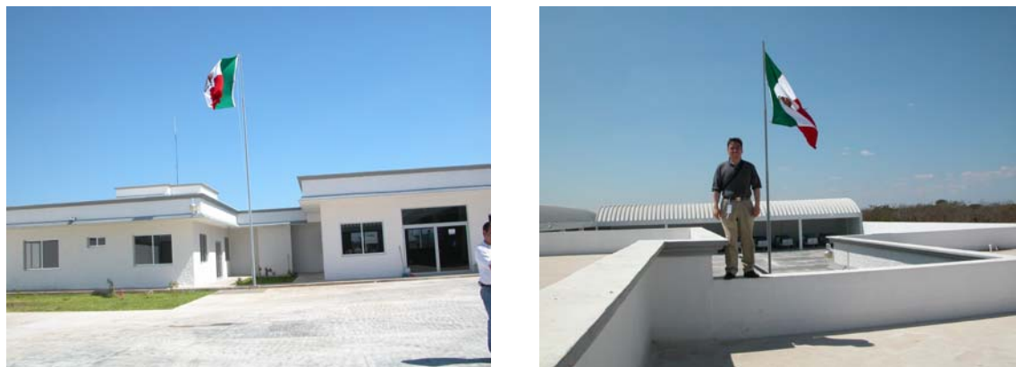
Figura IV-8. Segundo sitio probable. Instalaciones del Centro Regional de Atención de Emergencias (CRAE), Mérida, Yucatán.
