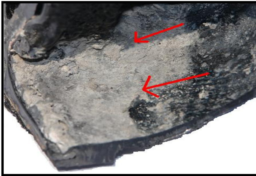
Figura 3.20 En este corte es evidente la degradación del polímero.
