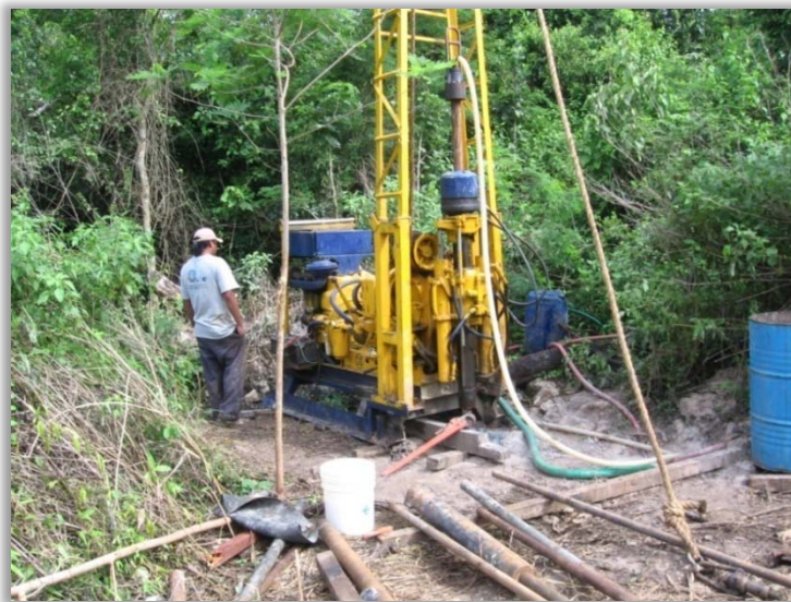
Fotografía 3. Donde se aprecia el Equipo de perforación Long Year T-34, empleado durante la barrenación.
