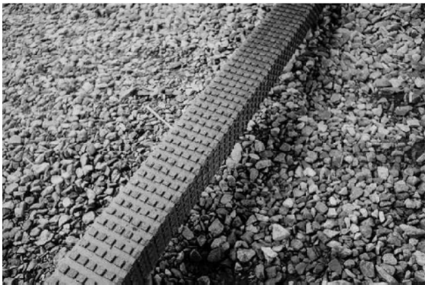
Figura 1.9 Durmiente de plástico con un patrón superficial para aumentar la estabilidad lateral 10) .
