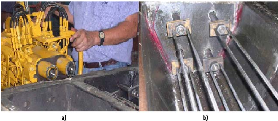
Figura 1.6 a) Máquina tensadora de la armadura de los durmientes de hormigón. b) Molde de vaciado para durmientes pretensados de hormigón HERSO .
