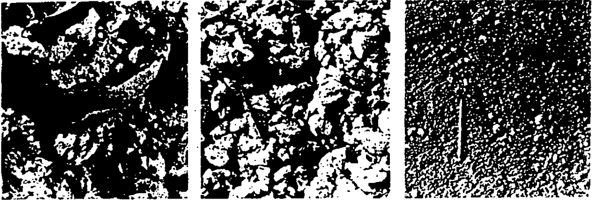
FIG. 2. Estas secuencias fotográficas muestran la trituración de arcilla pesada en un proyecto con cal en Florida. A la izquierda, las condiciones de la arcilla después del esparcido con cal y de la primera pasada con una rastra de disco (nótese el tamaño de los terrones). Al centro, las condiciones de quebrado después de dos pasadas con una mezcladora rotatoria; y derecha, después de varias pasadas, la arcilla ha sido transformada a una condición de desmenuzamiento, para facilitar la compactación.
