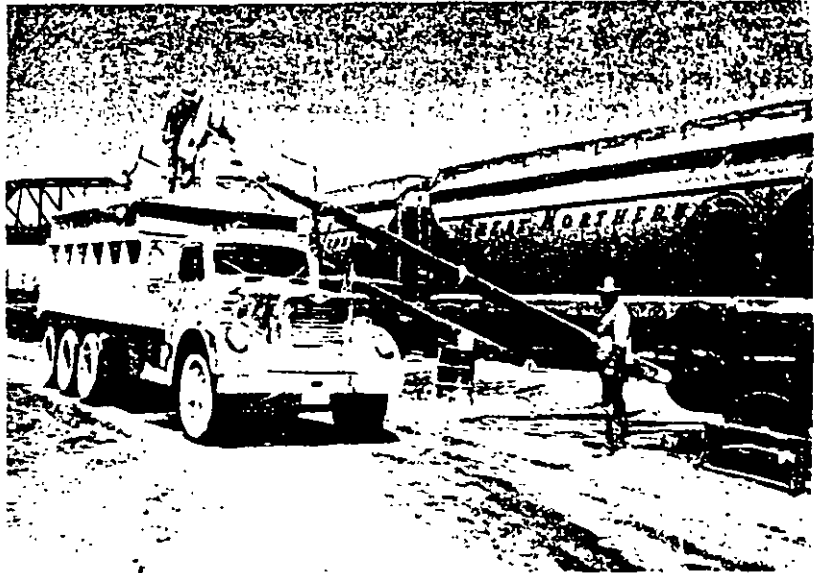
FIG. 8. Dos transportadores de gusano de alta velocidad transfiriendo la cal de una tolva de ferrocarril cerrada a un camión de colteo cubierto, en un proyecto en Dakota del Norte.
