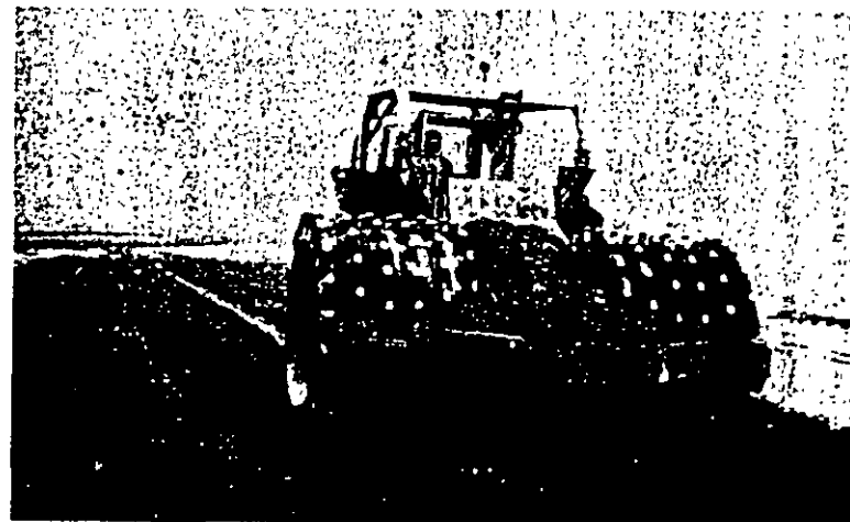
Escenas de estabilización en el Aeropuerto Dallas Fort Worth, el proyecto más grande de estabilización con cal del mundo. Las fotos muestran el esparcido de lechada de cal, la escarificación con un grado de raíces, el mezclado con una mezcladora rotatoria, y la compactación con un rodillo de patas de cabra.
