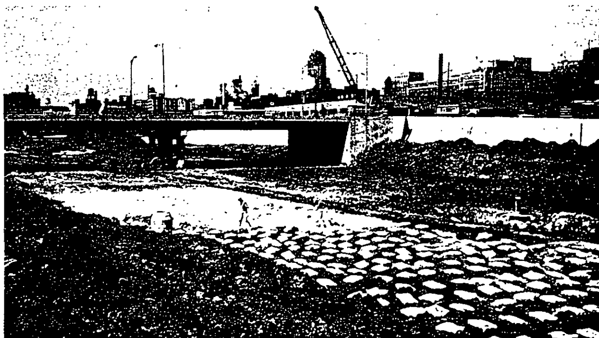
FIG. 6. Aplicación de cal envasada en un camino de acceso en Chicago.
