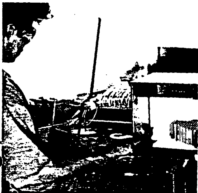
Figura 5A. Disposición de la línea troncal de E-Cord, sobre la cara de un túnel.
