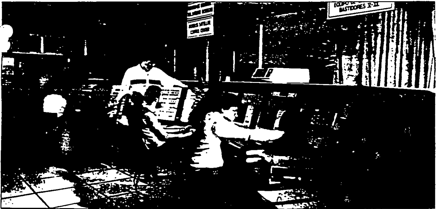
El centro de control de satélites actual, ubicado en Iztapalapa, será mejorado para manejar el sistema Solidario, el cual es más complejo.
