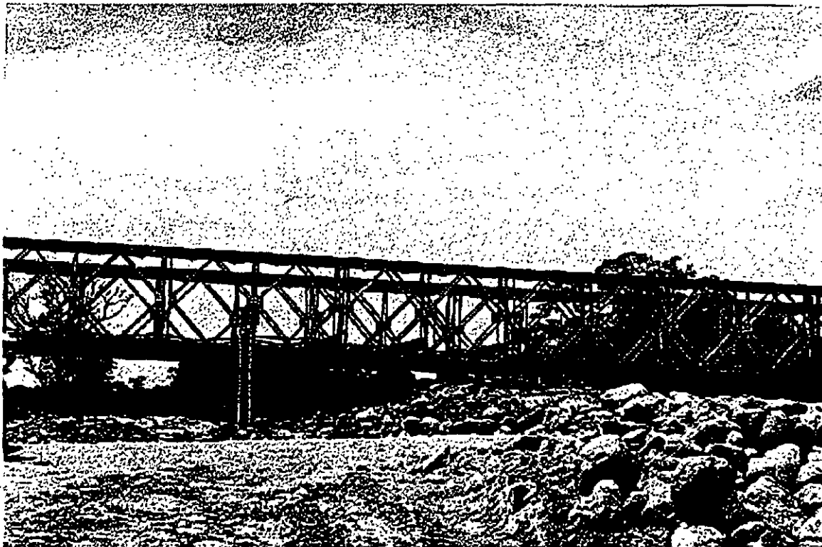
Figura 10. Construcción del terraplén auxiliar al centro del claro aproximadamente.
