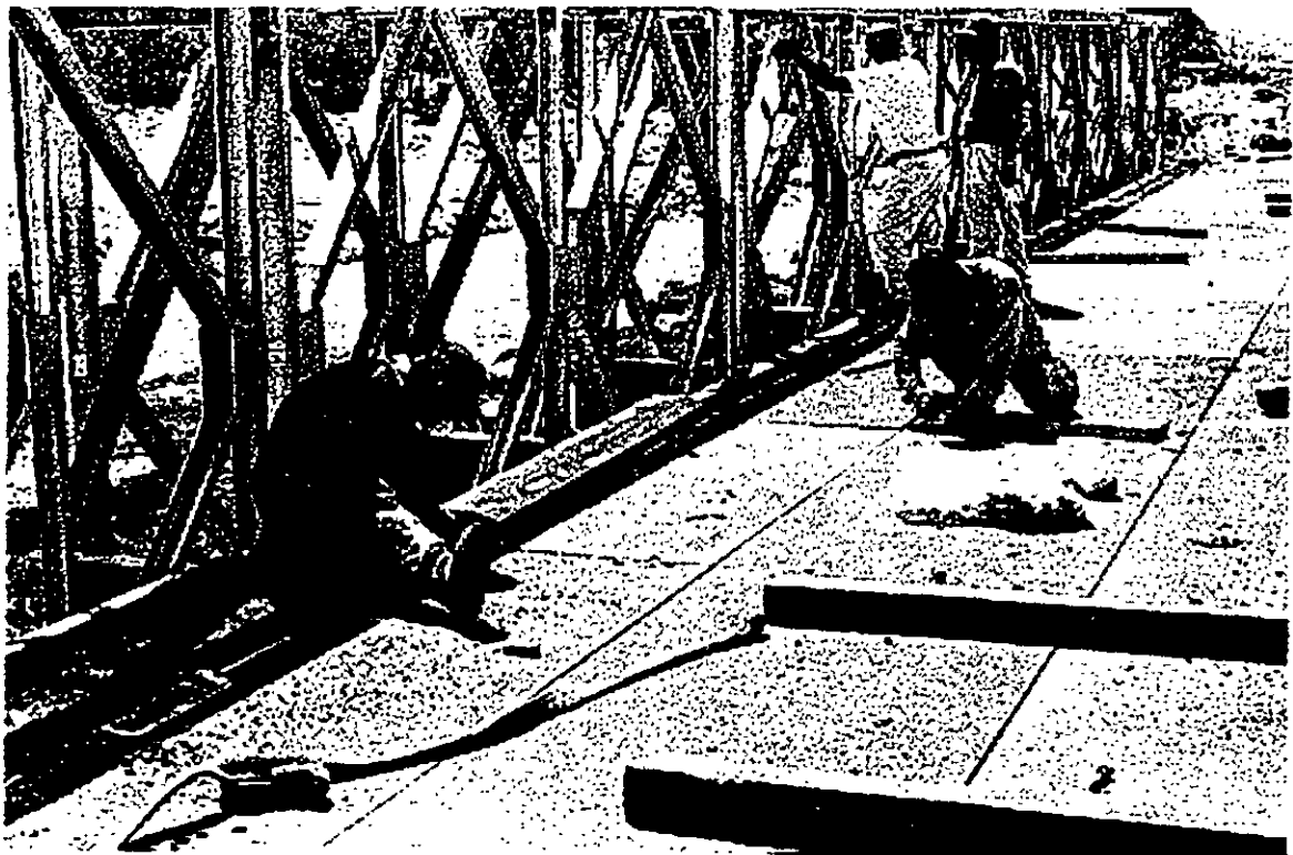
Figura 16. Sistema de piso.
