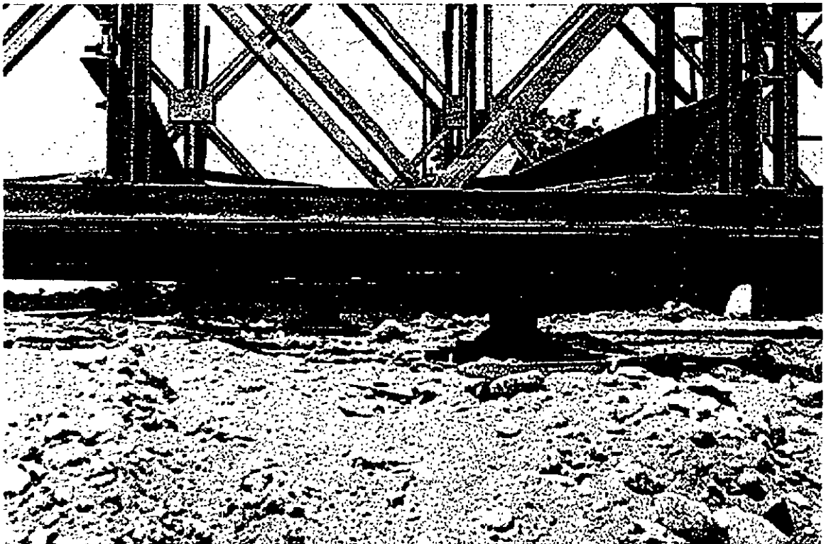
Figura 5. Apréciase el rodillo basculante, que es recomendable que se coloque en la parte más cercana al borde del terraplén de lanzamiento.
