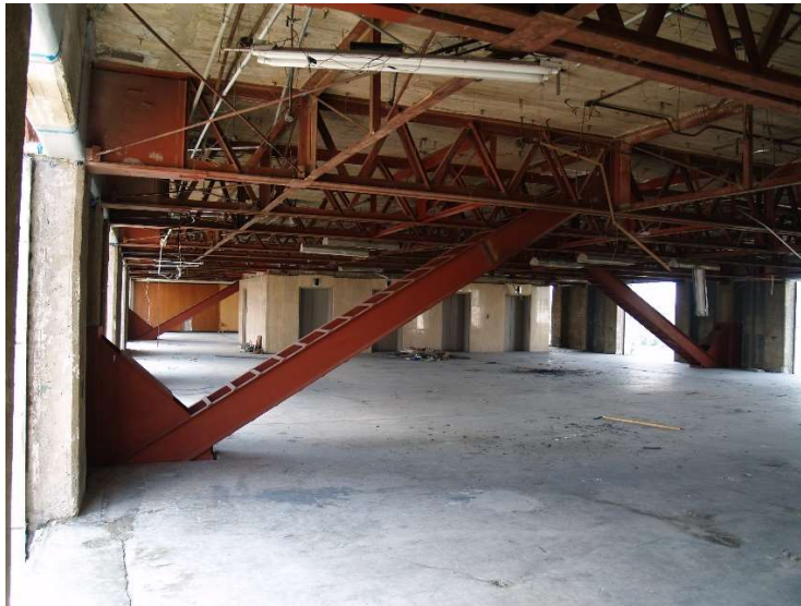
Fig. 2.14 Contravientos de rehabilitación en superestructura
