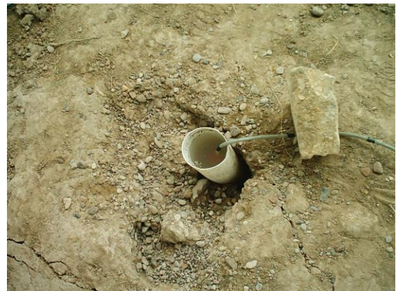
Sonda de geofonos colocada en el interior del pozo
